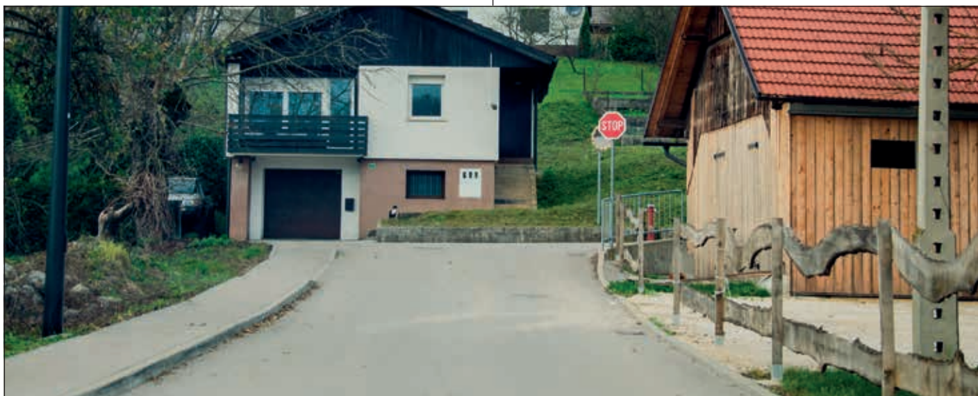
Ureditev cest in varne šolske poti na Rudniku.
