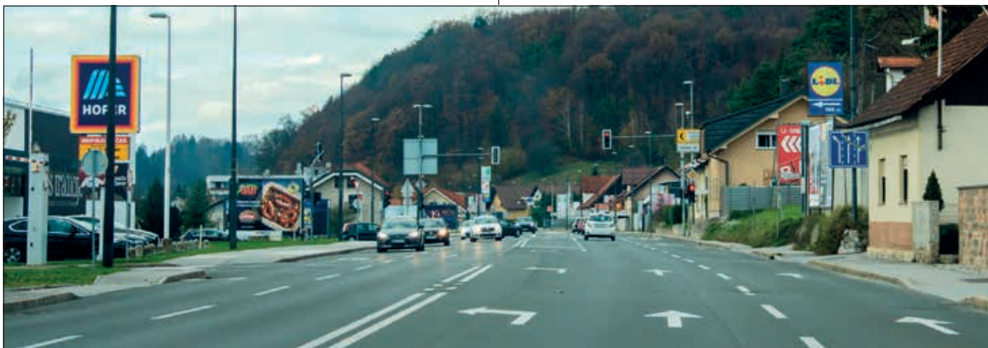
Na semaforiziranem križišču je dodana rumena luč za zavijanje levo, iz Dolenjske ceste proti NS Rudnik.
