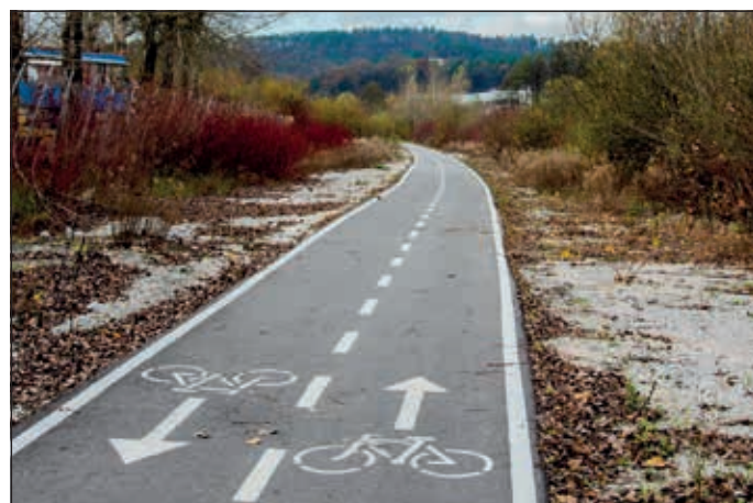
Urejanje kolesarskih poti v četrtni skupnosti je v pripravi, del kolesarskih poti pa je že na novo urejen. Na sliki je del poti ob Cvetkovi ulici.
