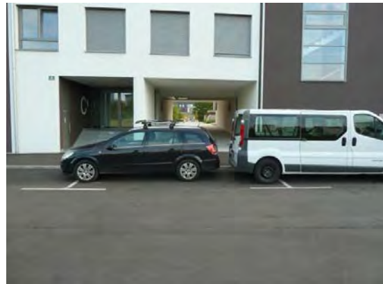
10. Pogled na prehod skozi objekt Jelinčičeva ulica 10
