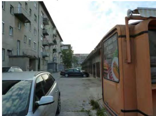
4. Pogled na večstanovanjski objekt ob Pokopališki
