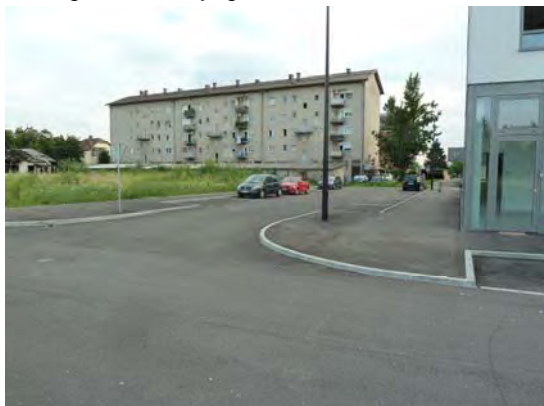
3. Pogled na večstanovanjski objekt ob Pokopališki
