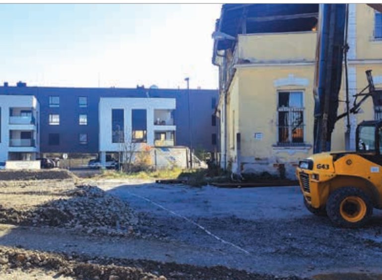
Začela so se gradbena dela za nov družbeni center Barje.
