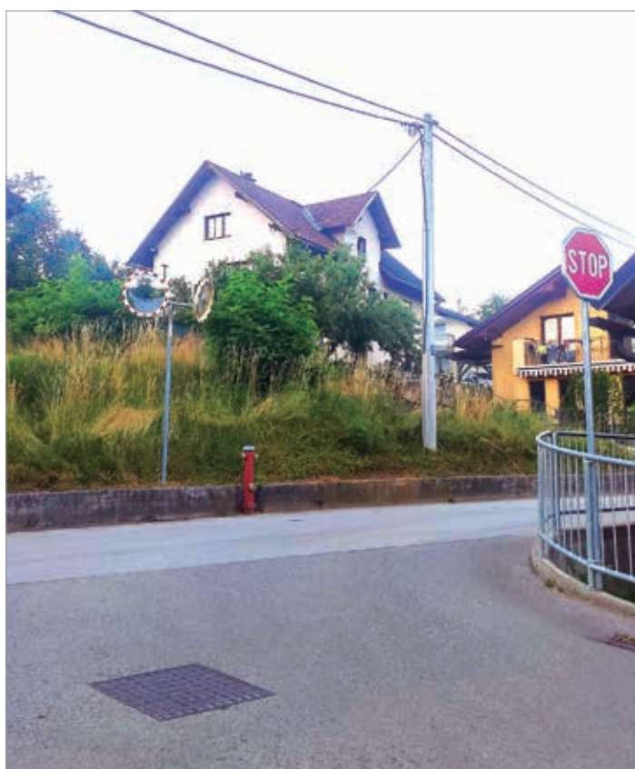
Na več lokacijah je bila postavljena prometna signalizacija.
