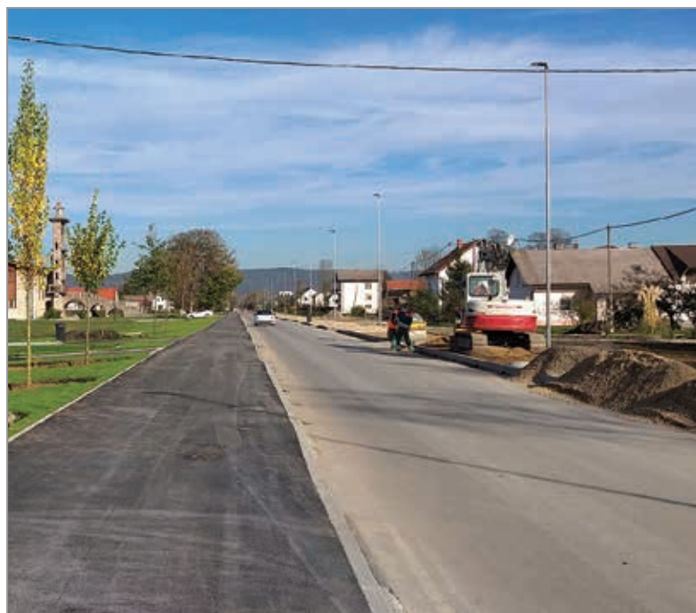
Prvi kilometer črnaške ceste se bliža zaključku.
