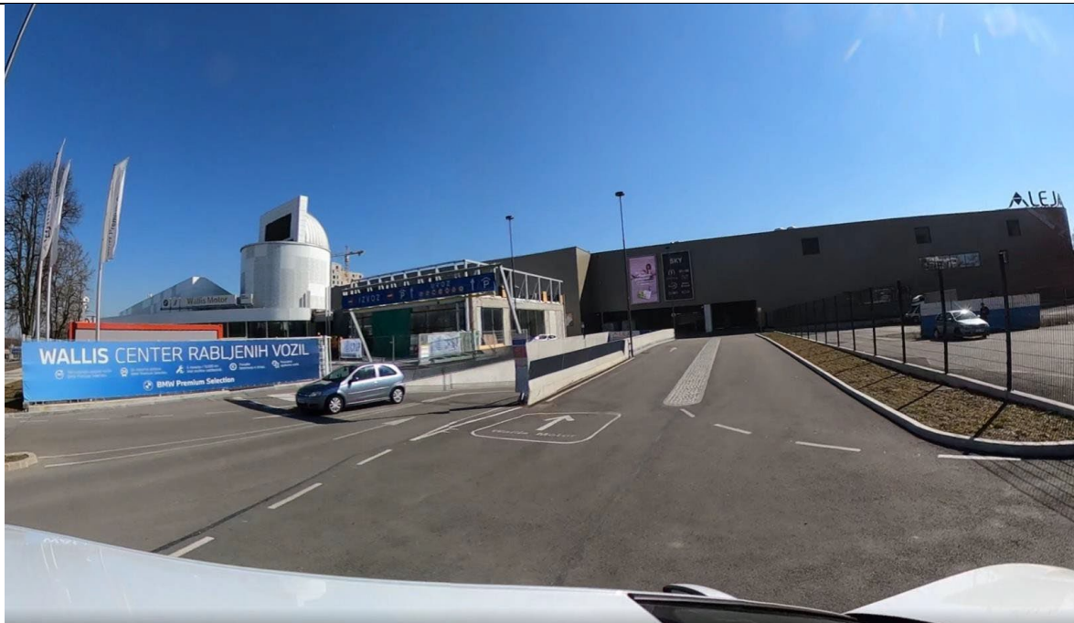
Slika 3: Obstoječa vozna pasova ob uvozno/izvozni rampi
