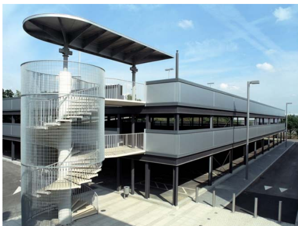
Slika 51: Večnivojsko parkirišče z jekleno konstrukcijo Vir: https://www.steelconstruction.info/
