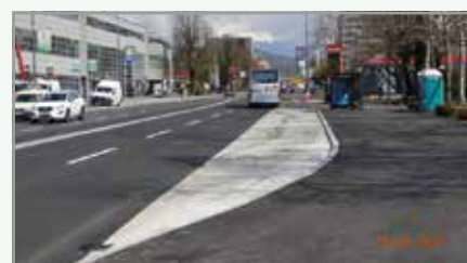
Obnovitvena dela in obnovljena Dunajska cesta
