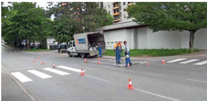
Na območju ČS Črnuče so delavci podjetja Javna razsvetljava poskrbeli za obnovo talnih označb.
