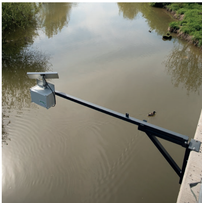
Slika 28 IŽICA, MOST NA IŽANSKI CESTI, KAROLINKE, MOST - 02
