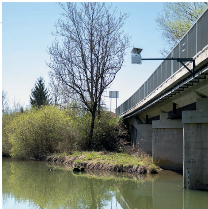
Slika 27 IŽICA, MOST NA IŽANSKI CESTI, KAROLINKE, MOST - 01
