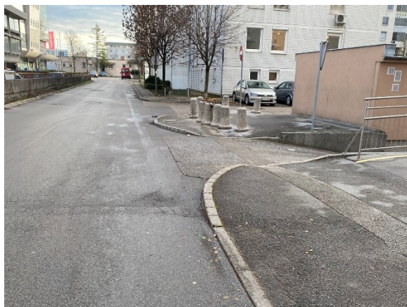
Slika 21: Enostranski hodnik za pešce vzdolž Mašera-Spasičeve ulice na odseku med Herbersteinovo ulico in Dunajsko cesto
