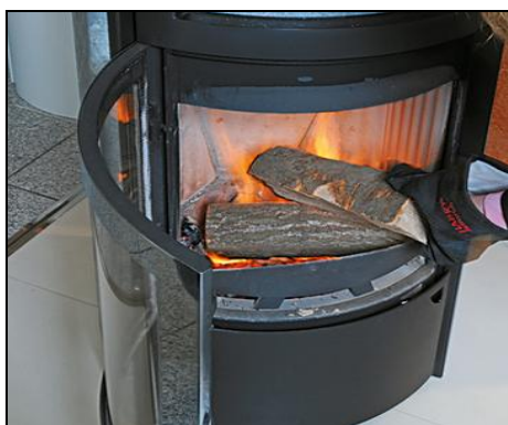
Slika 73; Po pogorelih drveh prve naložitve se za naslednjo naložitev doda le nekaj polen na žerjavico (Vir: www.heimwerkerlexikon.selbermachen.de )
