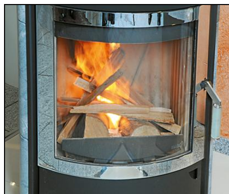
Slika 72; Začetek zgorevanja prve naložitve (Vir: www.heimwerkerlexikon.selbermachen.de )
