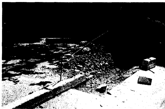
Popravilo pločnika na Pečnikovi ulici
