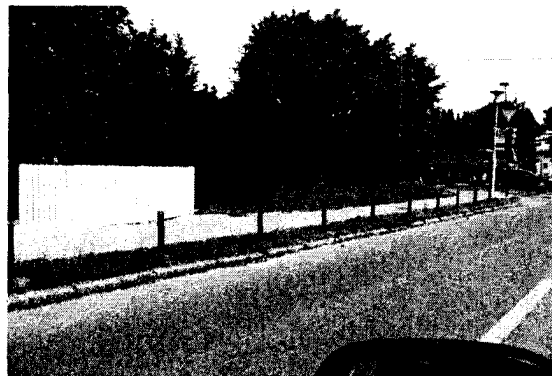
Postavitev zapornih stebričkov na Posavskega ulici
