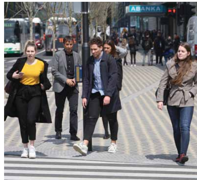
Znižani nivojski prehodi in talne čepaste opozorilne oznake na prehodu za pešce (foto: Nik Rovani)
