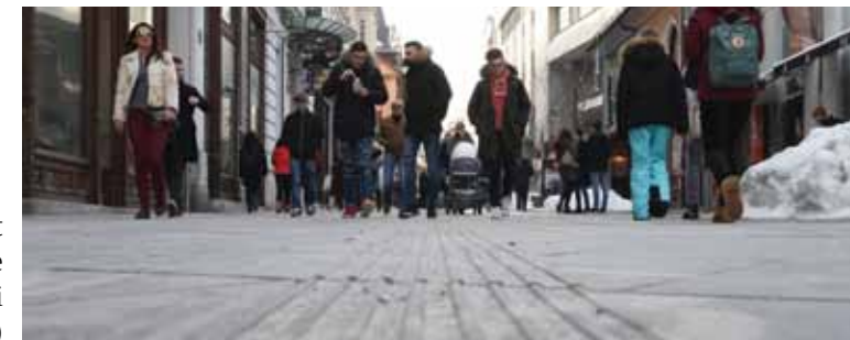
Vodilna taktilna pot na območju ekološke cone na Čopovi ulici (foto: Nik Rovan)
