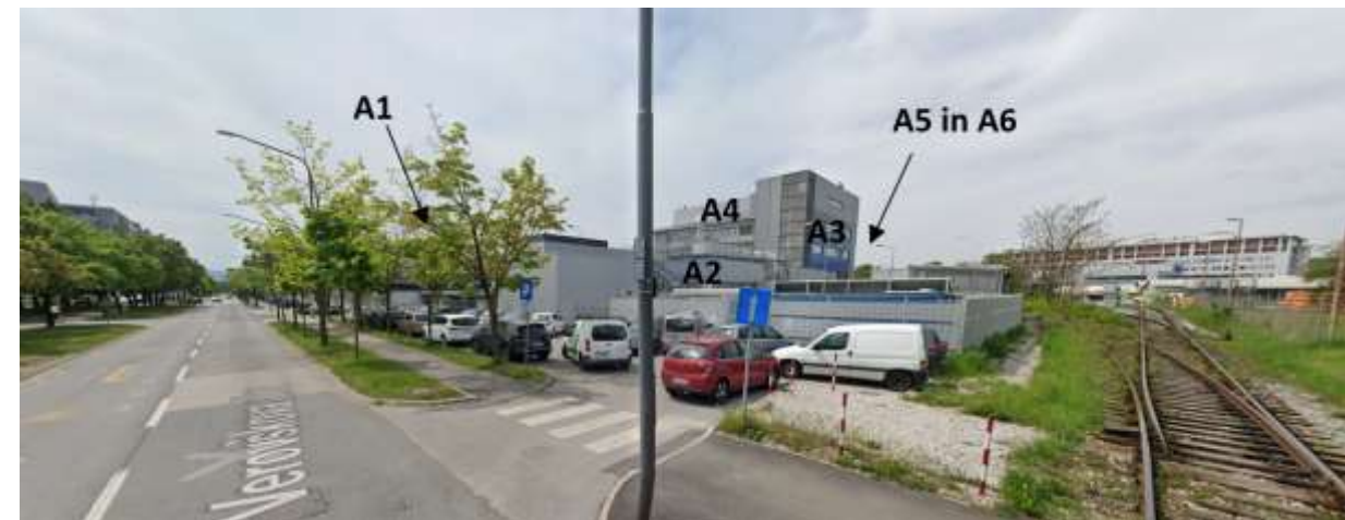
Pogled 1: Pogled na SZ vogal območja proti stavbam (A1, A2, A3, A4, A5 in A6) na križišču Verovškove ulice in industrijskega tira (vir: Google maps)
