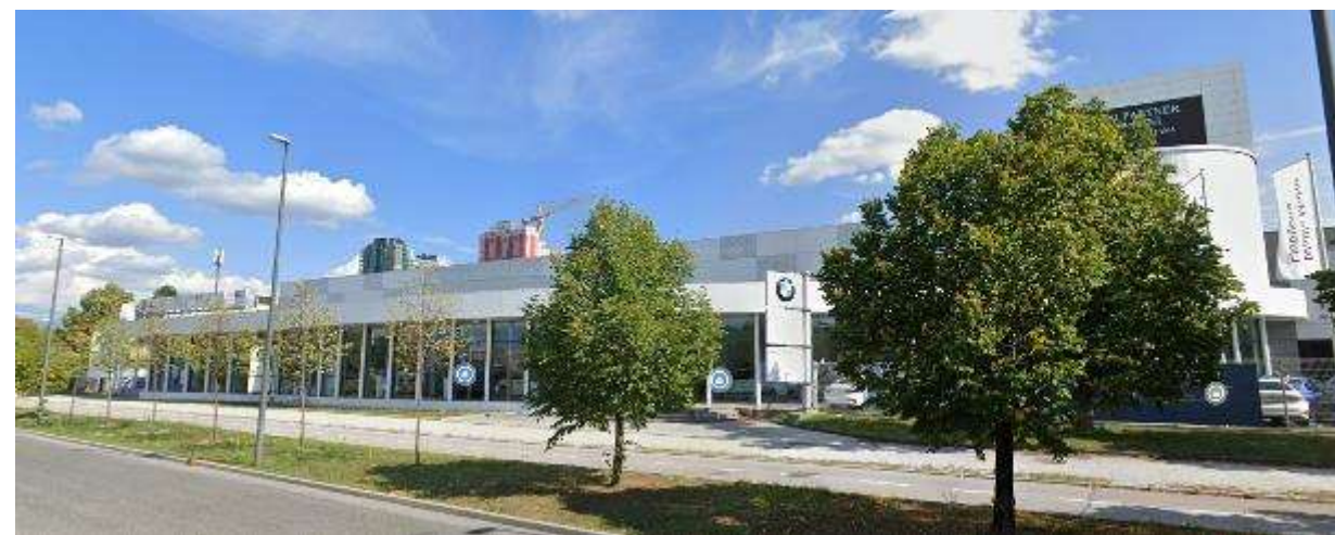
Pogled 1: Objekt A (poslovna stavba A-Cosmos)
