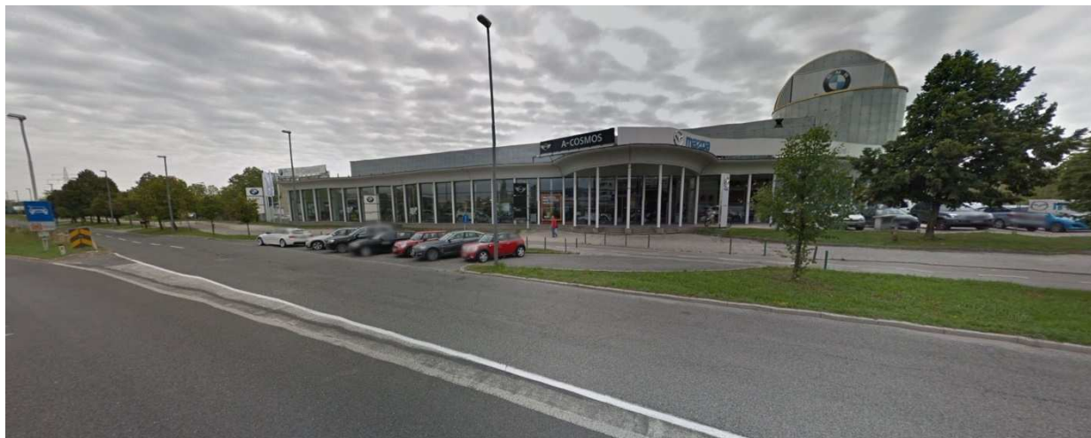
Slika 24: Pogled s severne obvozne ceste proti stavbi A (vir: Google map)
