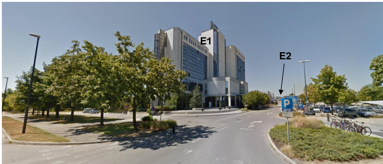
Slika 30: Pogled s V roba območja (z Verovškove ulice) proti notranjosti območja in objektu E1 in E2 (vir: Google maps)
