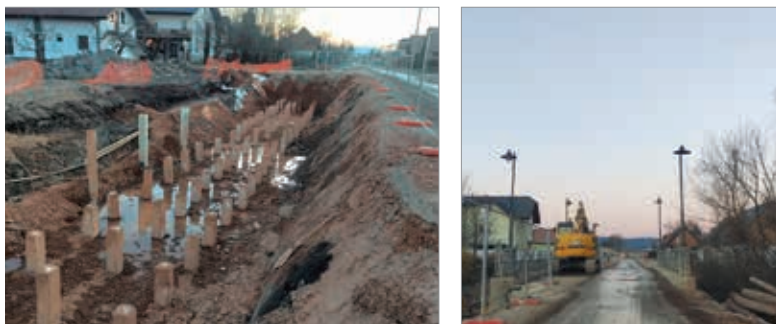
Črna vas med gradnjo kanalizacije
