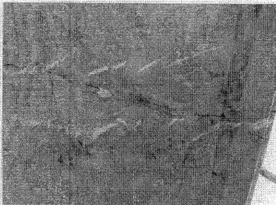
Sl. 2a in 2b: Razpoke v liniji žil v kamnu
