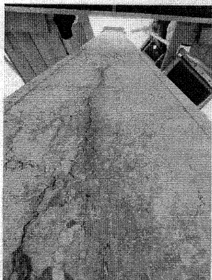
Sl. 3a in 3b: Vertikalne razpoke
