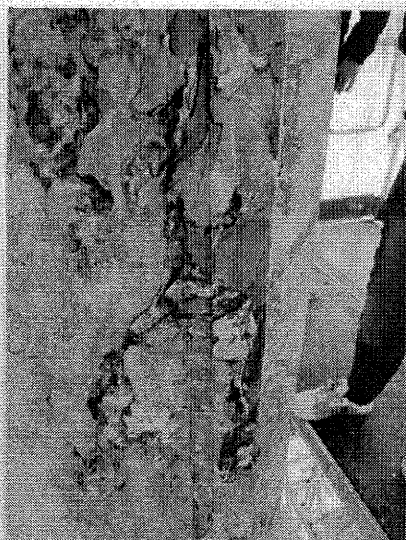
Sl. 4a in 4b: Začetek luščenja kamna na površini z gosto mrežo žil ter luščenje kamna
