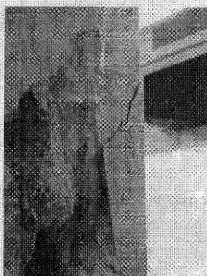
Sl. 4a in 4b: Začetek luščenja kamna na površini z gosto mrežo žil ter luščenje kamna
