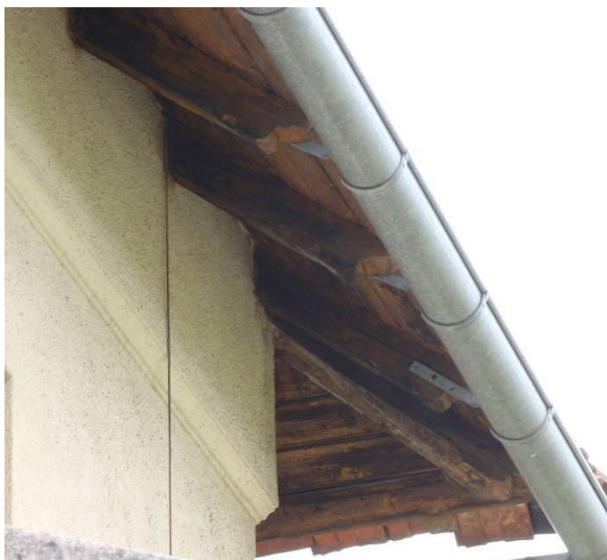
Vidni les (špirovci, opaž) pod odkapom.
