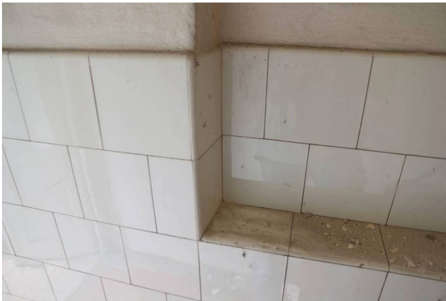
Stenske keramične ploščice, bele, dimenzij 15 x 15 cm.
