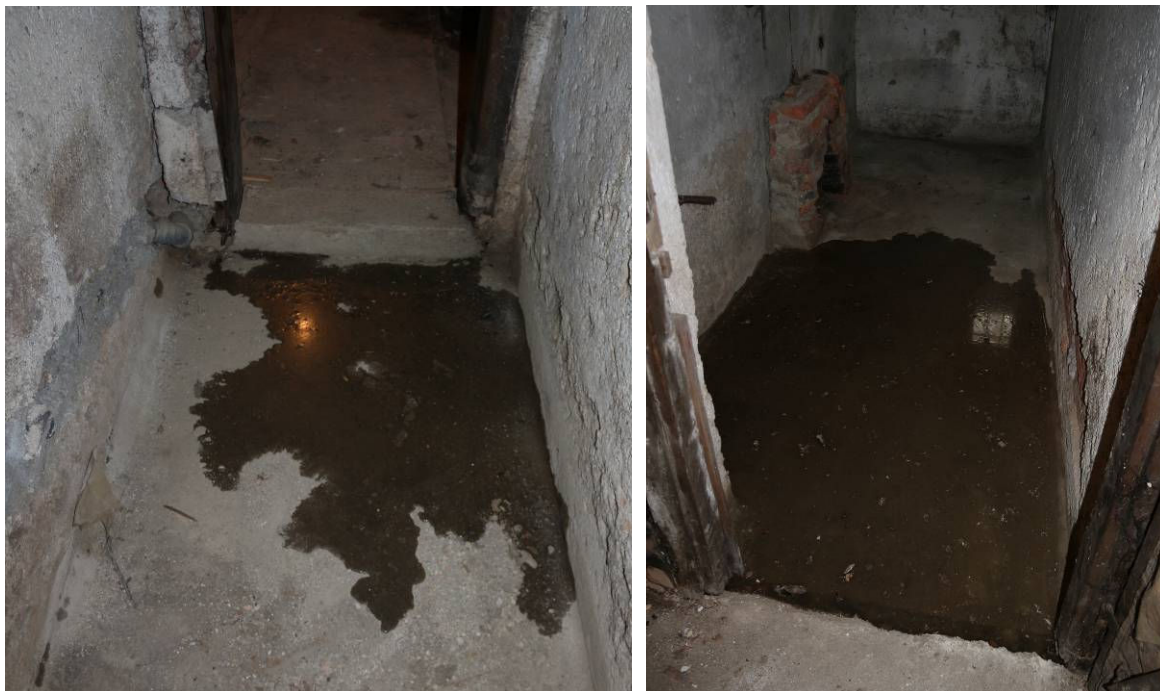
Vdiranje podtalne vode pri vratnih pragovih v prostorih K13 (levo) in K10 (desno).
