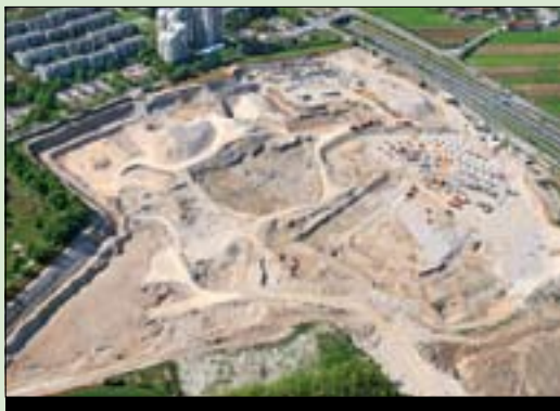
V gradnji sta športna objekta stadiona v Stožičah.
