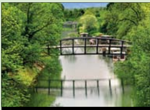
Zgrajena je brv na Špici.
