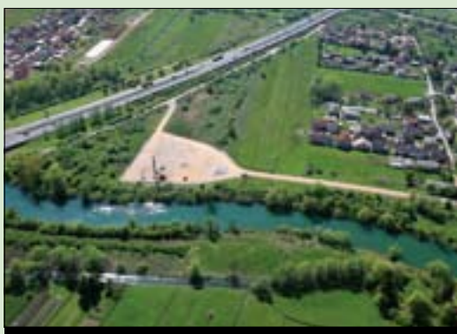
Obnova kanalizacijskega sistema na Rakovi jelši poteka po termiskem načrtu
