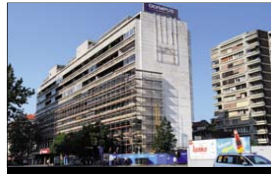
Začela se je težko pričakovana prenova Kozolca.
