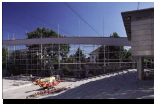
Poletno gledališče Krizanke bo letos dobilo povsem novo nosilno konstrukcijo.
