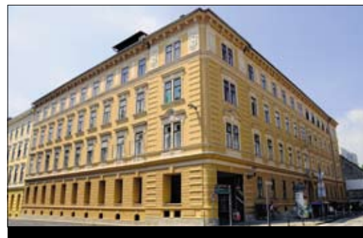
Prenovljena fasada na Slovenski 3.
