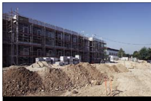
Intenzivno poteka gradnja nove OŠ Kašelj.
