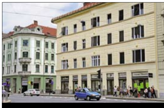
Prenovljena fasada Fabianijeve stavbe na Slovenski cesti, ki je bila last župana Ivana Hribarja.
