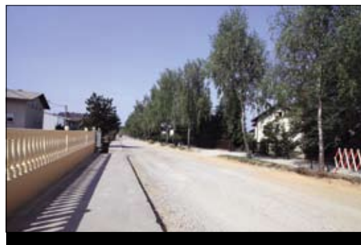
Intenzivno potekajo gradbena dela tudi na Peruzzijevi cesti.
