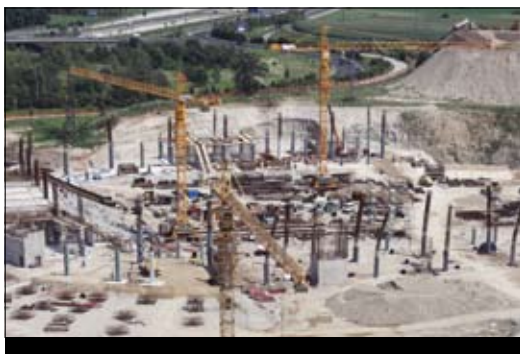
Gradnja Športnega parka Stožice z večnamensko dvorano poteka po načrtu.
