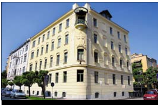
Prenovljena fasada stavbe na Prešernovi 3.
