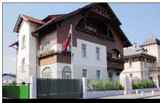
Prenovljena fasada Vidmarjeve vile na Cesti 27. aprila.
