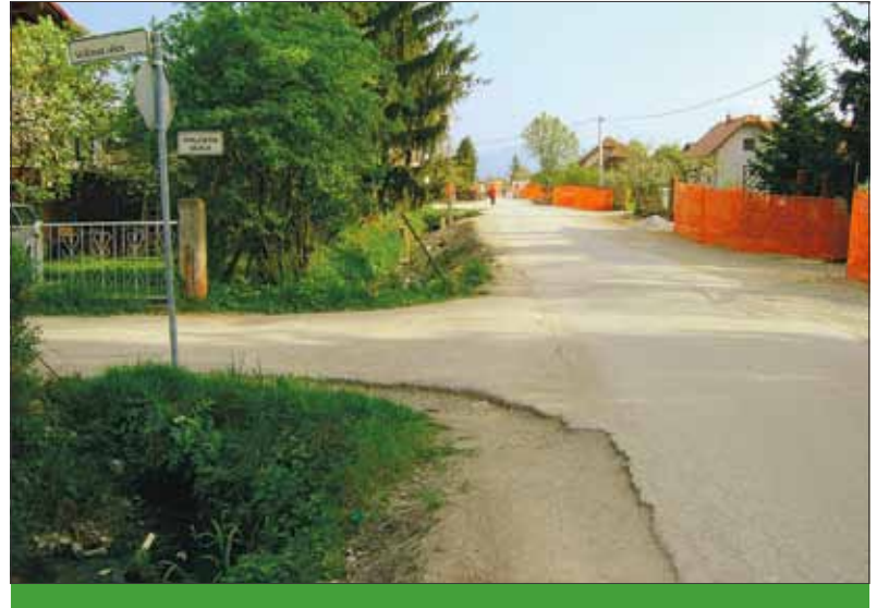
Rakova jelša pred začetkom gradnje komunalne infrastrukture.
