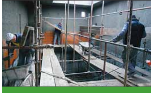
Gradnja lokalne čistilne naprave s podtlačno kanalizacijo.
