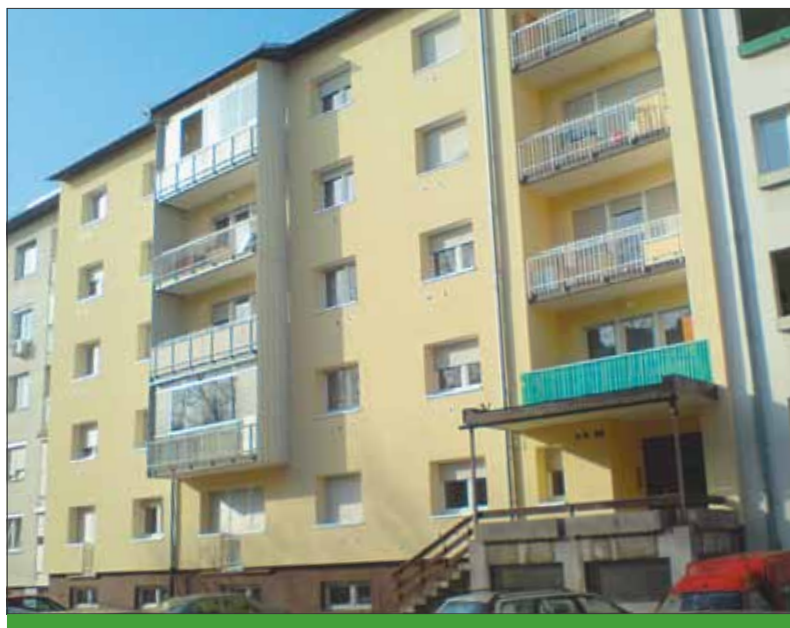
Javni stanovanjski sklad je toplotno zaščitil tudi stavbo na Kvedrovi ulici 17 in tako prihranil stroške svojim najemnikom.
