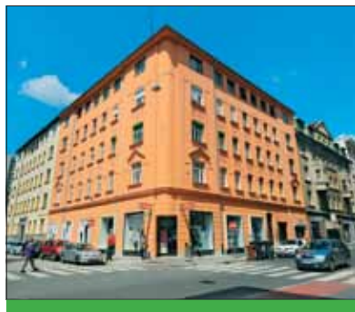
Vogalna stavba Miklošičeva 13-Pražakova 9.
