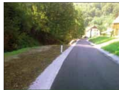
Besnica Gabrje LC po sanaciji.
