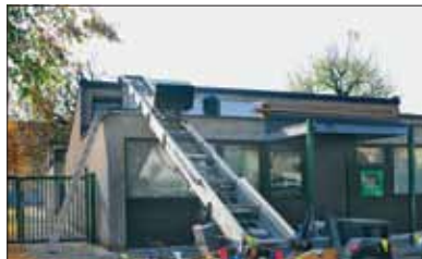
Foto: Dunja Wedam Zaključna faza prenove treh oddelkov v vrtcu Zelena jama, enoti Zmajčica.
