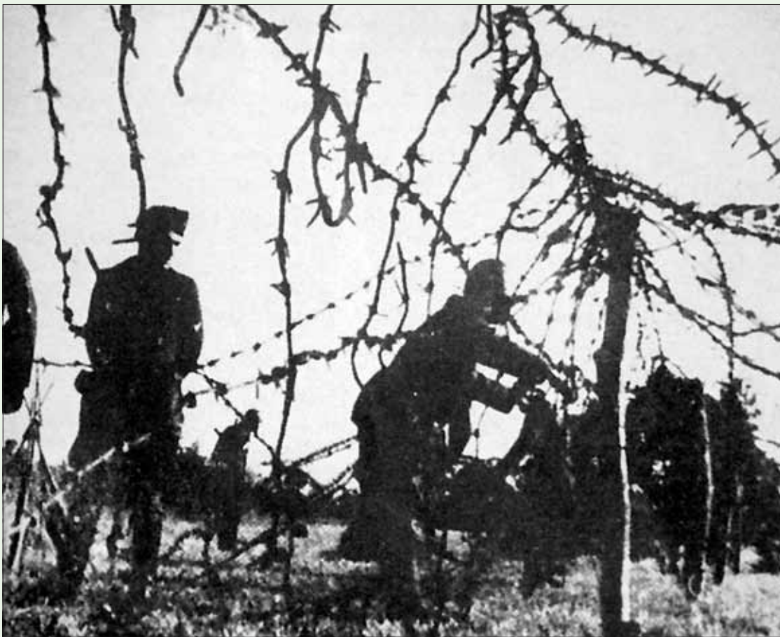
Gradnja žičnega obroča okoli Ljubljane.
