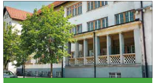
Septembra letos se začneja protipotresna sanacija, energetska sanacija in dozidava prizidka k OŠ Vide Pregarc.
