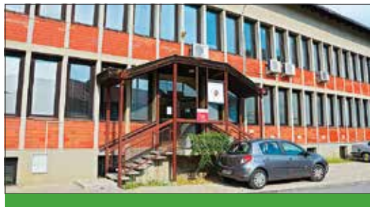
Od julija 2013 bo potekala II. faza prenove stavbe in ureditev poslovnega dela ter bivalnih enot na Belokranjski.
