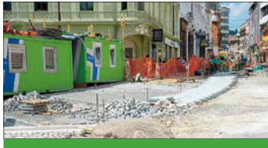
Celovita obnova podzemne komunalne infrastrukture, nove podzemne zbiralnice in nova oprema parterja na Čopovi je v zaključni fazi.
