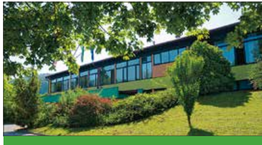
Julija 2013 se začela energetska sanacija OŠ Oskarja Kovačiča.
