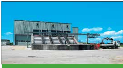
Izgradnja III. faze Centralne čistilne naprave Ljubljana se začela decembra letos.
