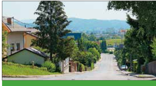
Začenja se gradnja komunalne infrastrukture na Cesti na Brdo, ki bo končana avgusta letos.
