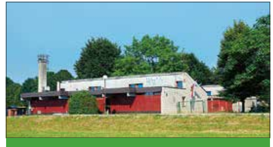
Avgusta letos se začneja rušenje in novogradnja Vrtca Otona Župančiča, enote Čebelica.
