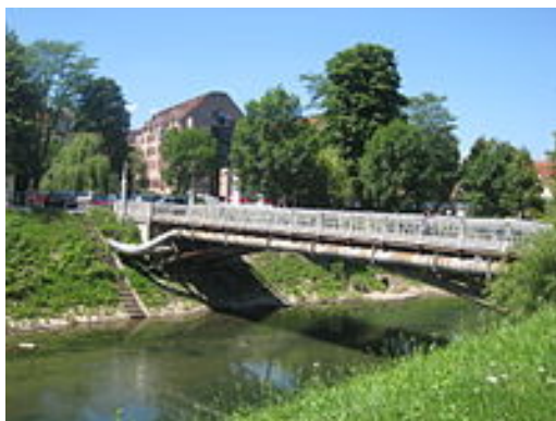
Nadomestni most v času rekonstrukcije
