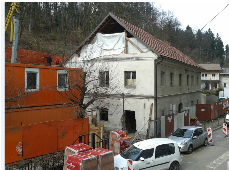
Fotografija: Stavba Vodnikova 5 med izvajanjem del
