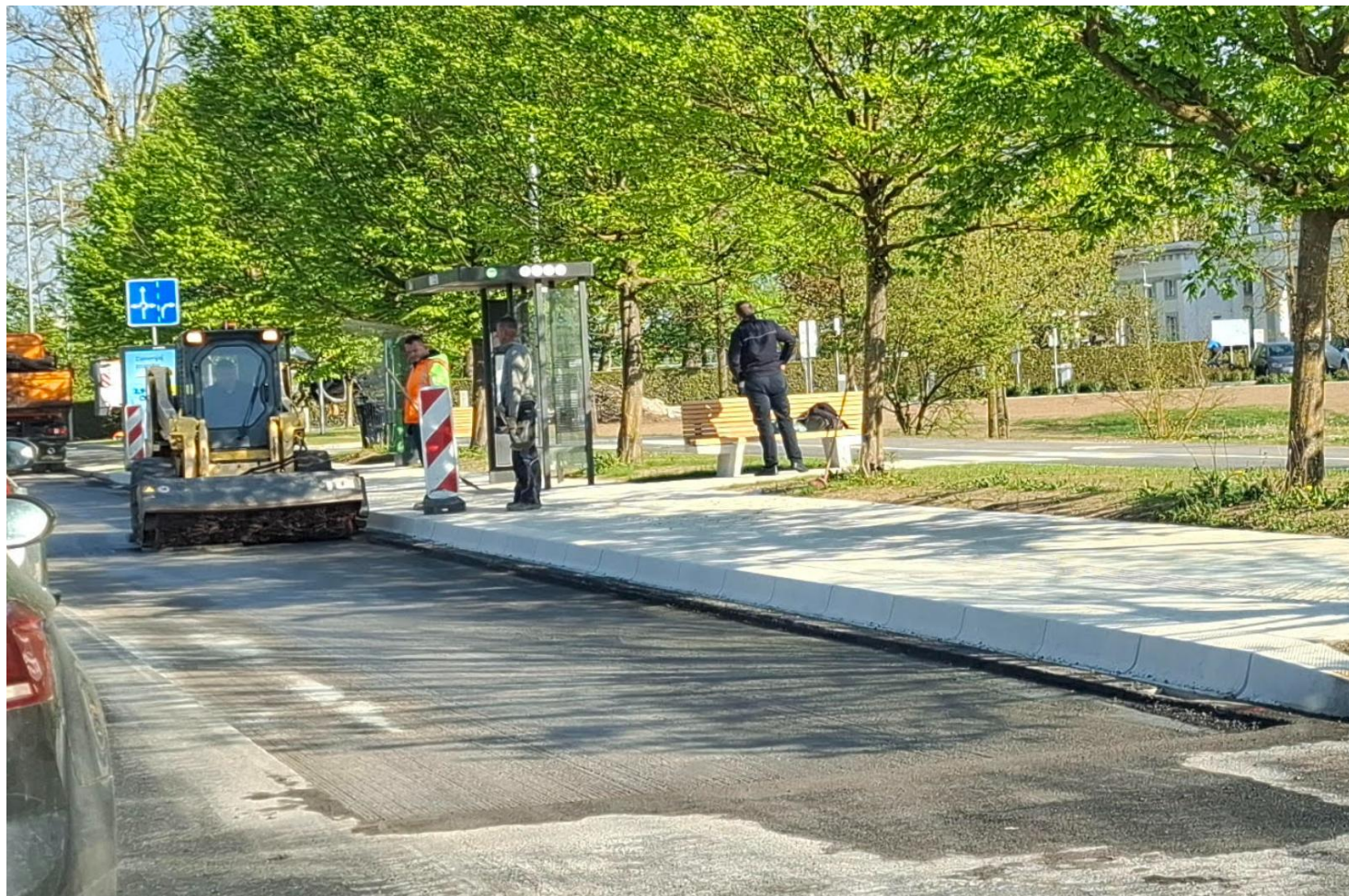
Priloga: Fotografija ponovne odstranitve asfalta na območju krožišča Žale
