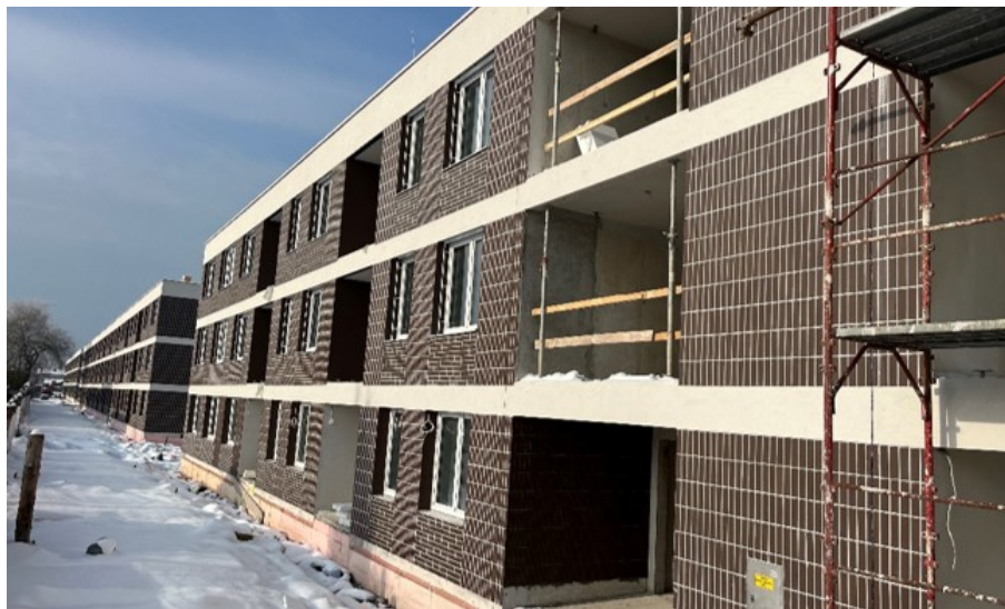
Gradbišče stanovanjske soseke Rakova jelša I (fotografija: arhiv JSS MOL, 2025)
