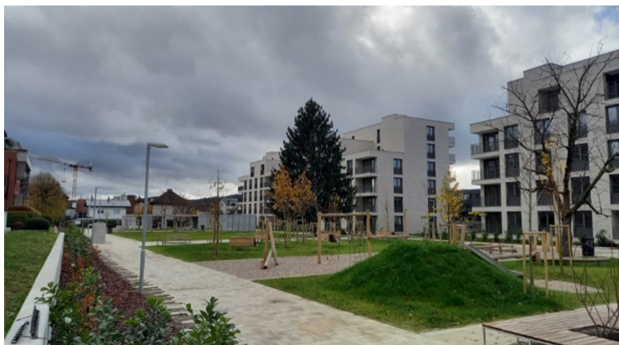
Zaključevanje gradnje stanovanjske soseske Zvezna ulica in javnega parka (foto: arhiv JSS MOL, november 2025)
