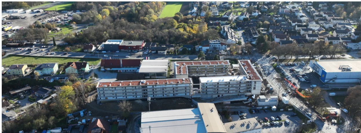
Gradbišče stanovanjske soseske Litijska Pesarska (fotografija: arhiv JSS MOL, 2025)
