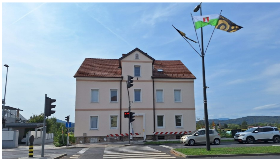
Ulična fasada sanirane stavbe Zaloška 160a. (foto: arhiv JSS MOL, oktober 2024)
