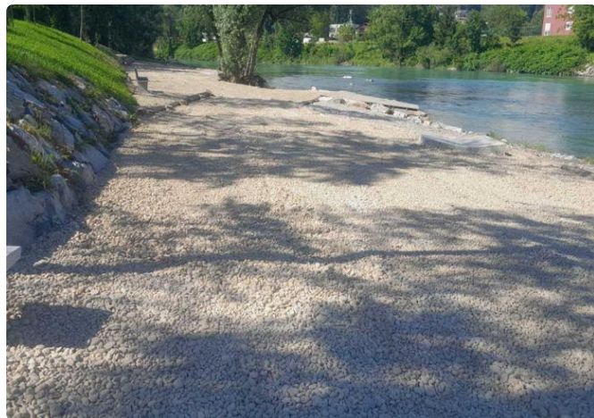
Slika 3: Plaža Laguna po opravljenih sanacijskih delih
