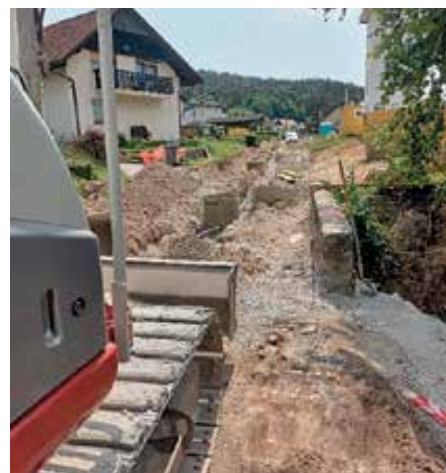
Gradnja kanalizacije na Sostrski cesti.
