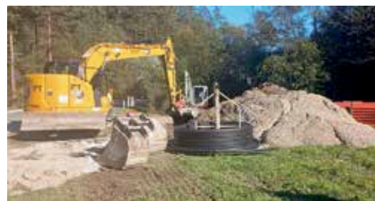
Začetek gradnje vodovoda Besnica.
