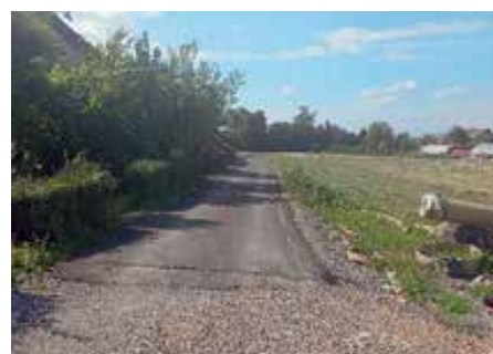
Prej makadamska cesta, po gradnji kanalizacije asfaltna (avgust 2025).
