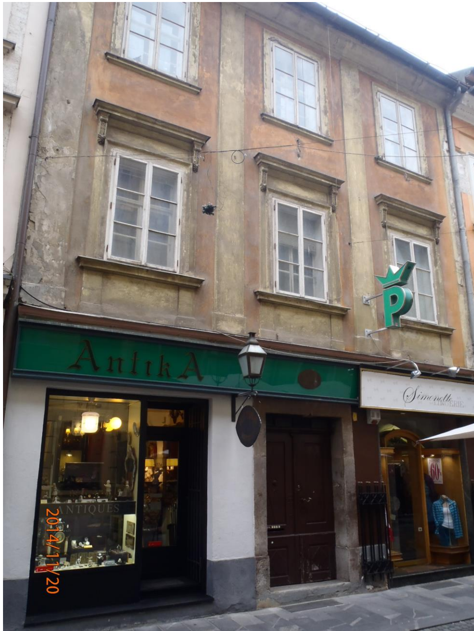
Stavba na naslovu Stari trg 24, Ljubljana
