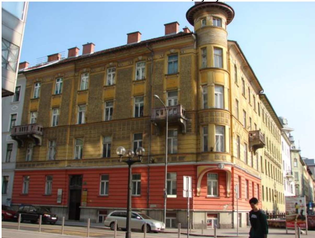
Stavba na Dalmatinovi ulici 7, Ljubljana
