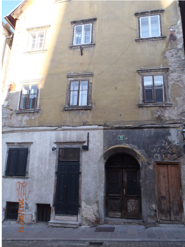
Stavba na Gornjem trgu 13, Ljubljana
