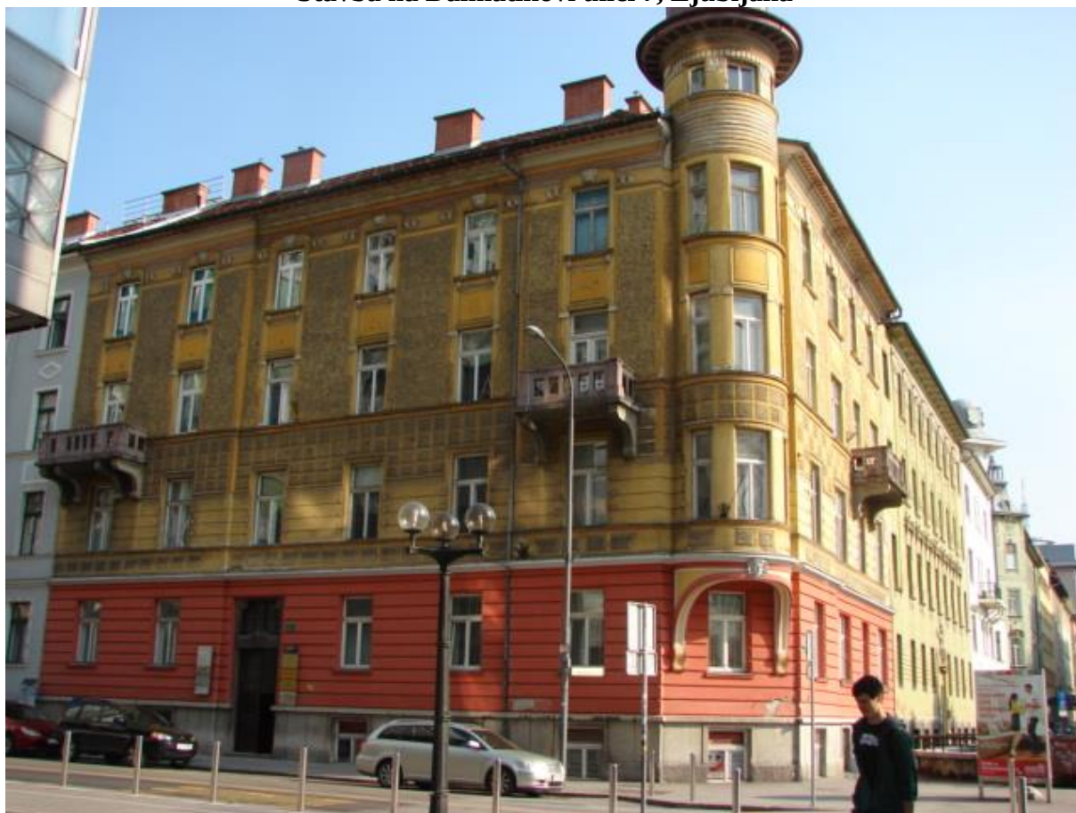
Stavba na Dalmatinovi ulici 7, Ljubljana
