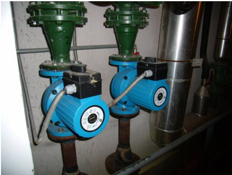
Slika 17: Navadne obtočne črpalke brez frekvenčne regulacije
