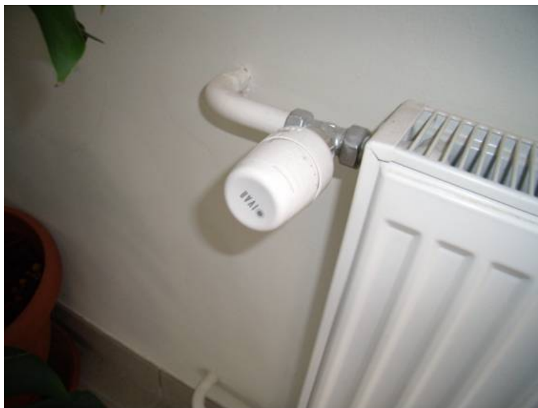
Slika 18: Radiator s termostatsko glavo
