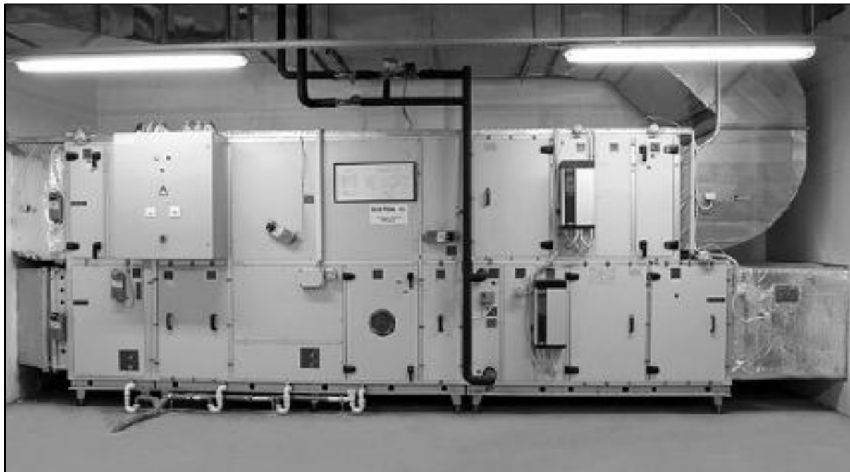
Slika 16: Modularna klimatska naprava za izkoriščanje odpadne toplote
