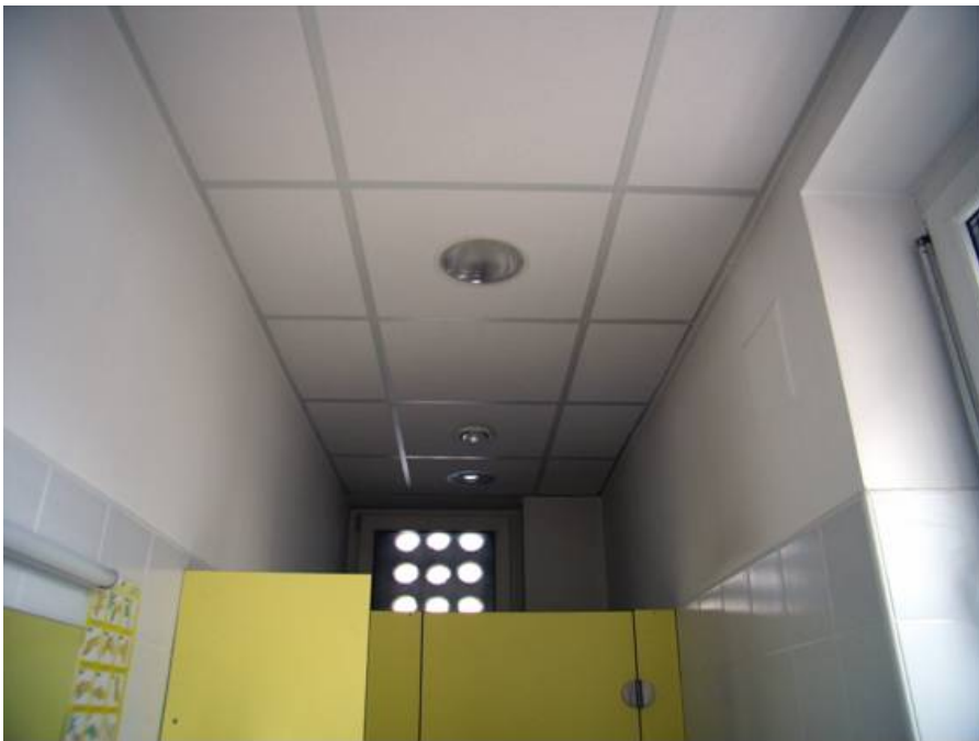
Slika 14: Varčna razsvetljava v sanitarijah pritličja, brez senzorja prisotnosti
