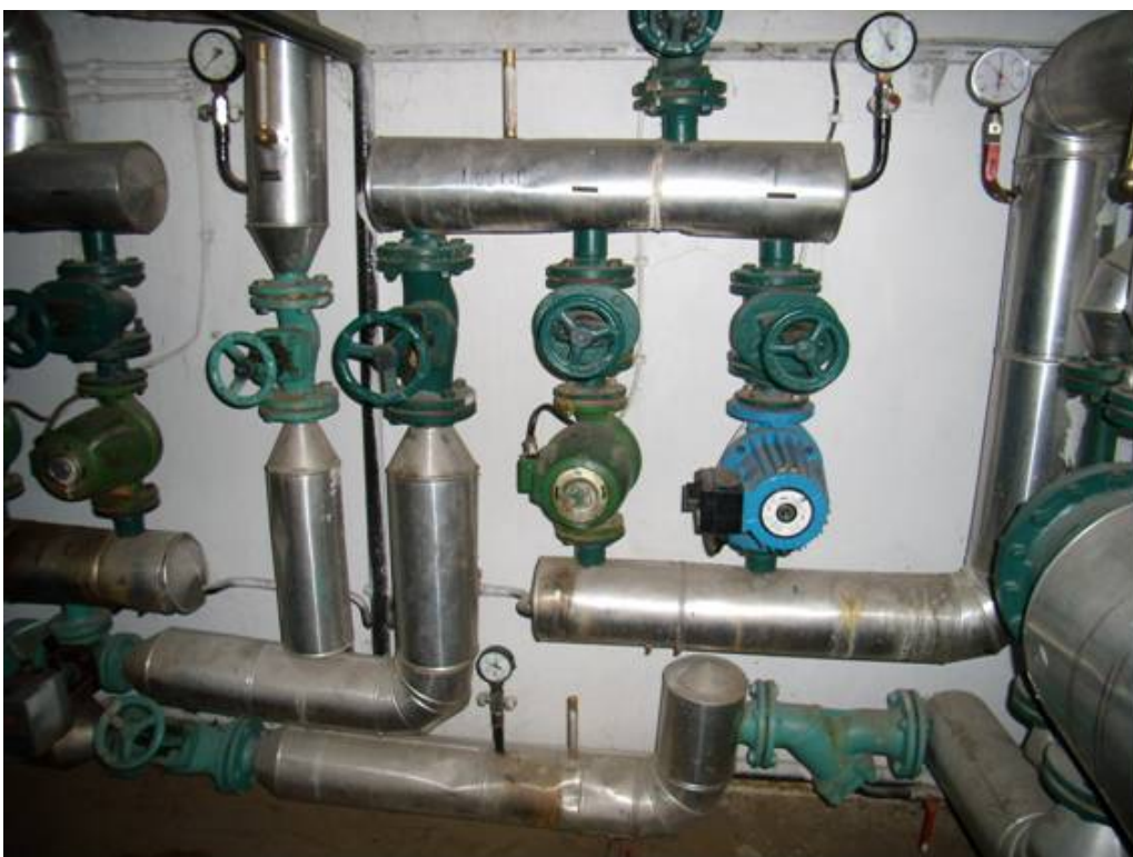
Slika 16: Toplotna podpostaja sekundarni del
