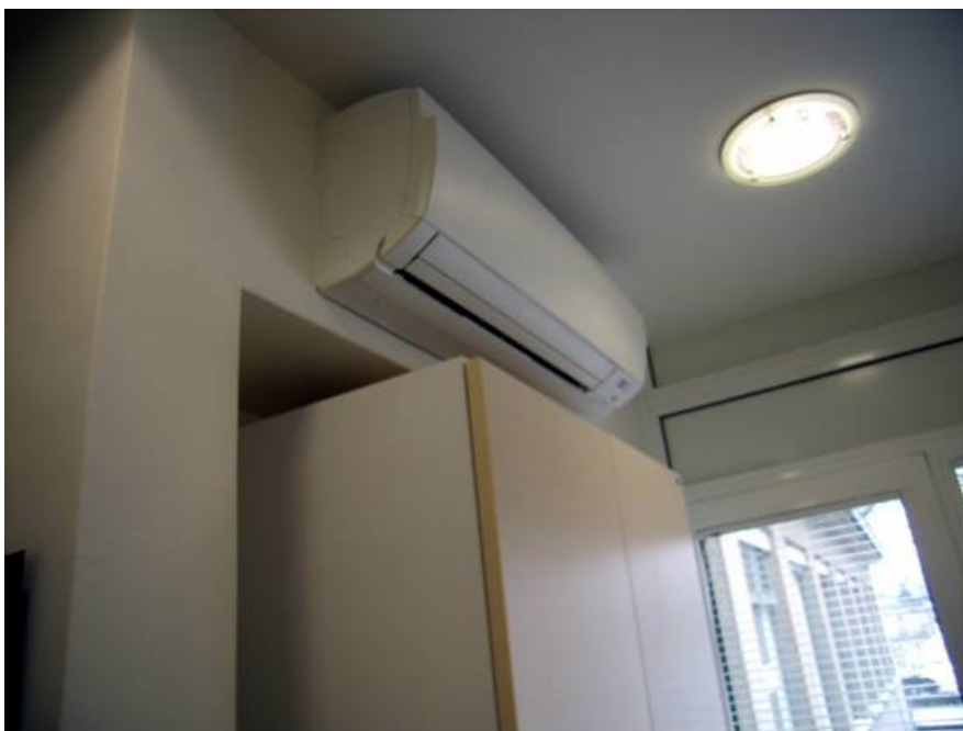
Slika 14: Vgrajena klima naprava moči 3,5 kW
