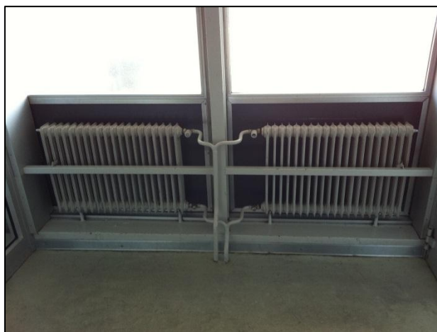
Slika 6: Radiatorsko ogrevanje z ročnimi regulacijskimi ventili
