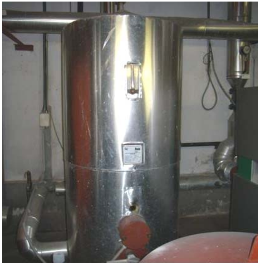
Slika 19: Hranilnik tople sanitarne vode V = 1.500 \text{ l}
