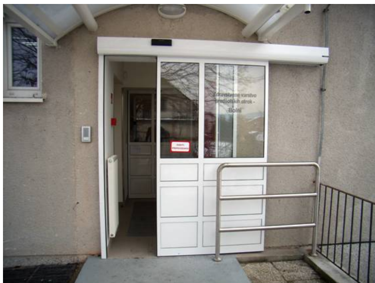
Slika 9: Vhodna avtomatska vrata
