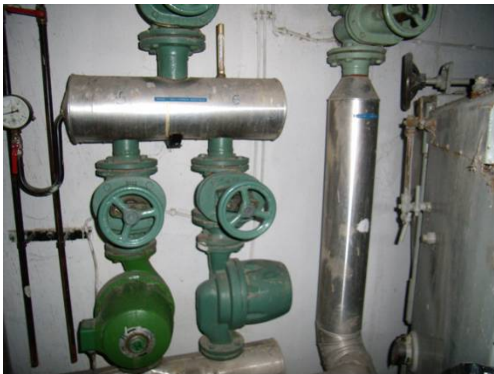
Slika 17: Toplotna podpostaja – dotrajane obtočne črpalke
