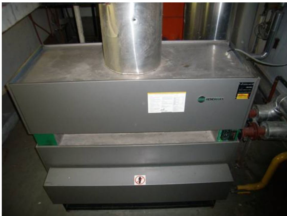
Slika 15: Atmosferski kotel Rendamax moči 340 kW
