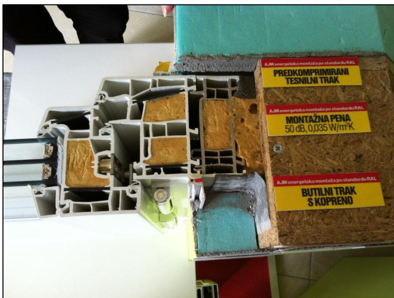
Slika 18: Primer vgradnje okna po smernicah RAL montaže s tesnjenjem okna v treh ravninah
