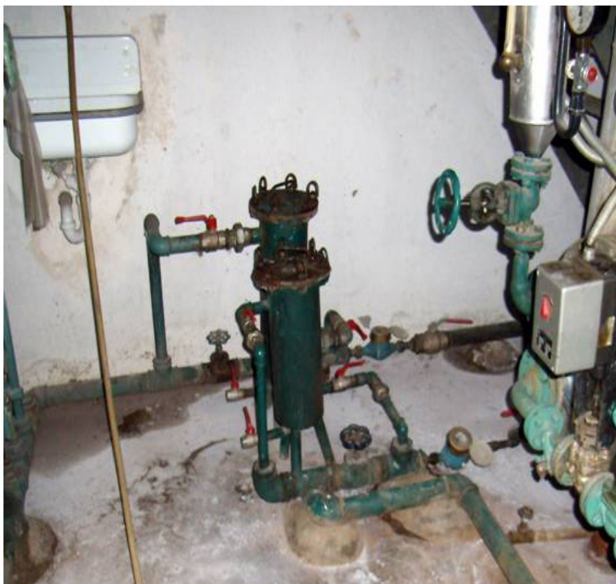
Slika 20: Zastarela priprava vode – mehčalna naprava
