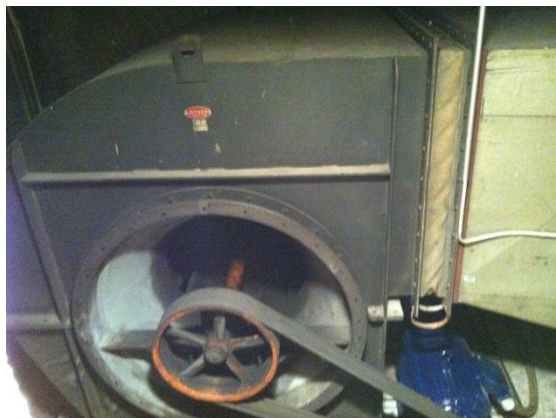
Slika 11: Glavni dovodni ventilator 20.000 \text{ m}^3/\text{h} za malo in veliko dvorano
