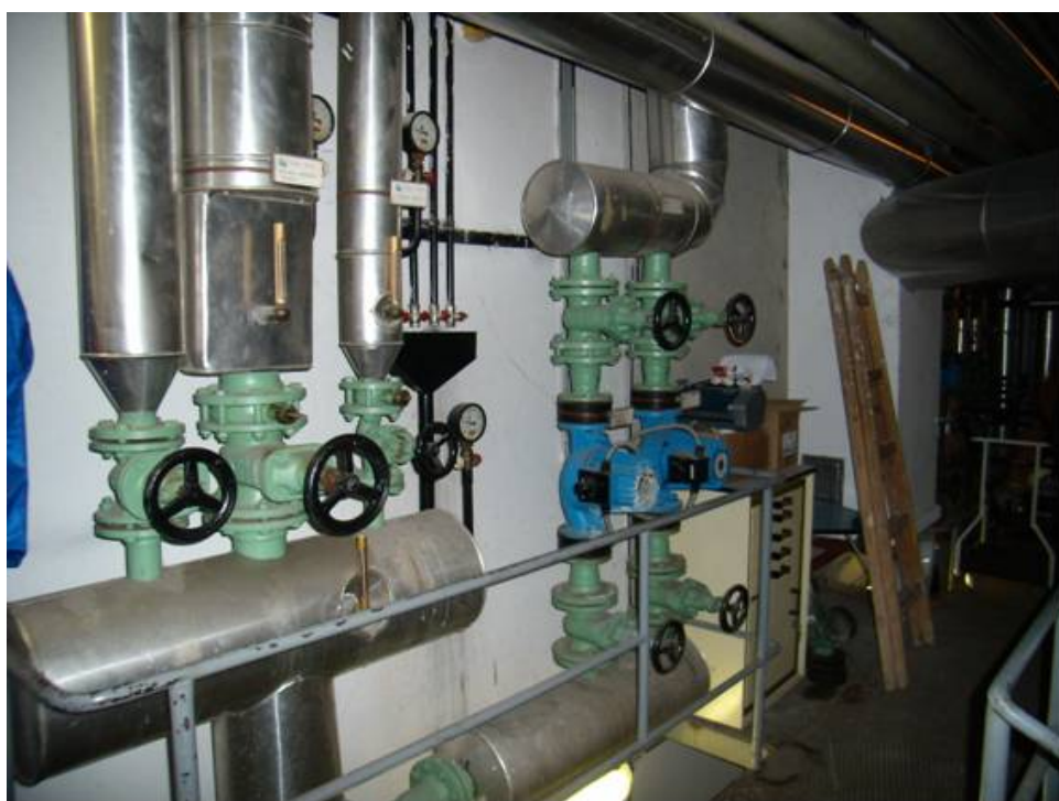
Slika 16: Neizolirani ventili
