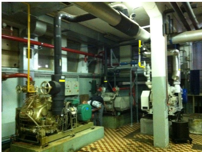
Slika 9: Hladilna strojnica s tremi hladilnimi kompresorji na amonijak
