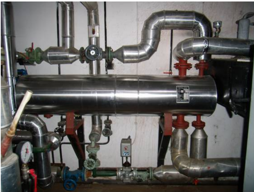
Slika 15: Toplotna postaja primarni del
