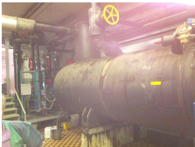
Slika 10: Tlačna posoda za hladilno sredstvo - amonijak
