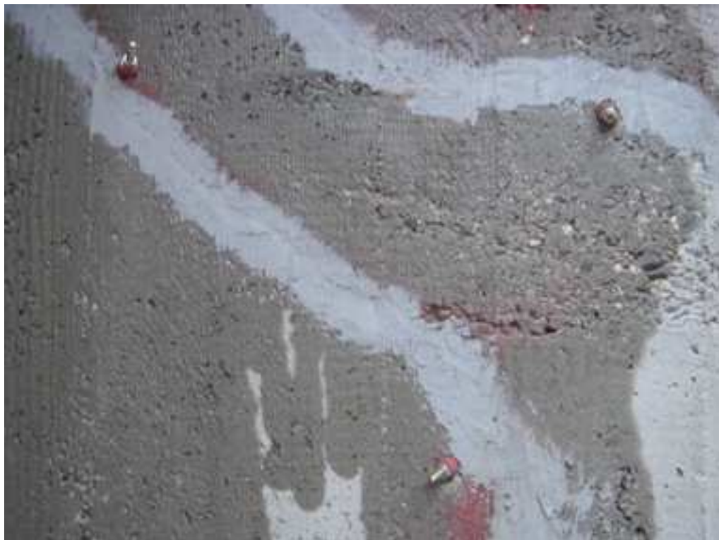
slika 9: garaža – prikaz vstavljenih pakerjev pripravljenih za injektiranje
