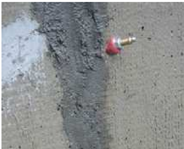
slika 10: garaža – prikaz vstavljenih pakerjev pripravljenih za injektiranje
