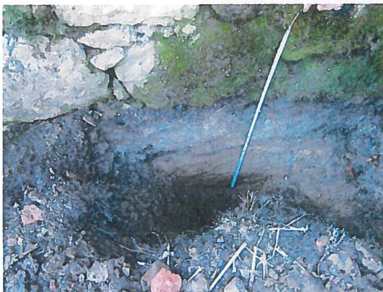
Slika 5: Sondažni izkop ZS-2
