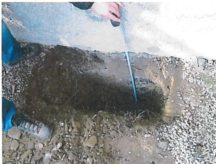
Slika 3: Sondažni izkop ZS-1
