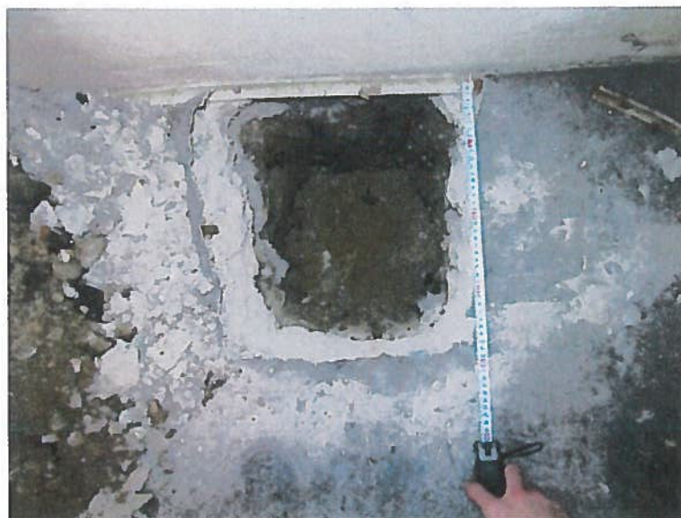
Slika 4: Sondažni izkop NS-2
