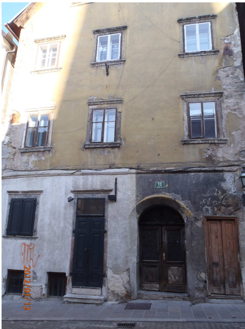
stavba Gornji trg 13, Ljubljana
