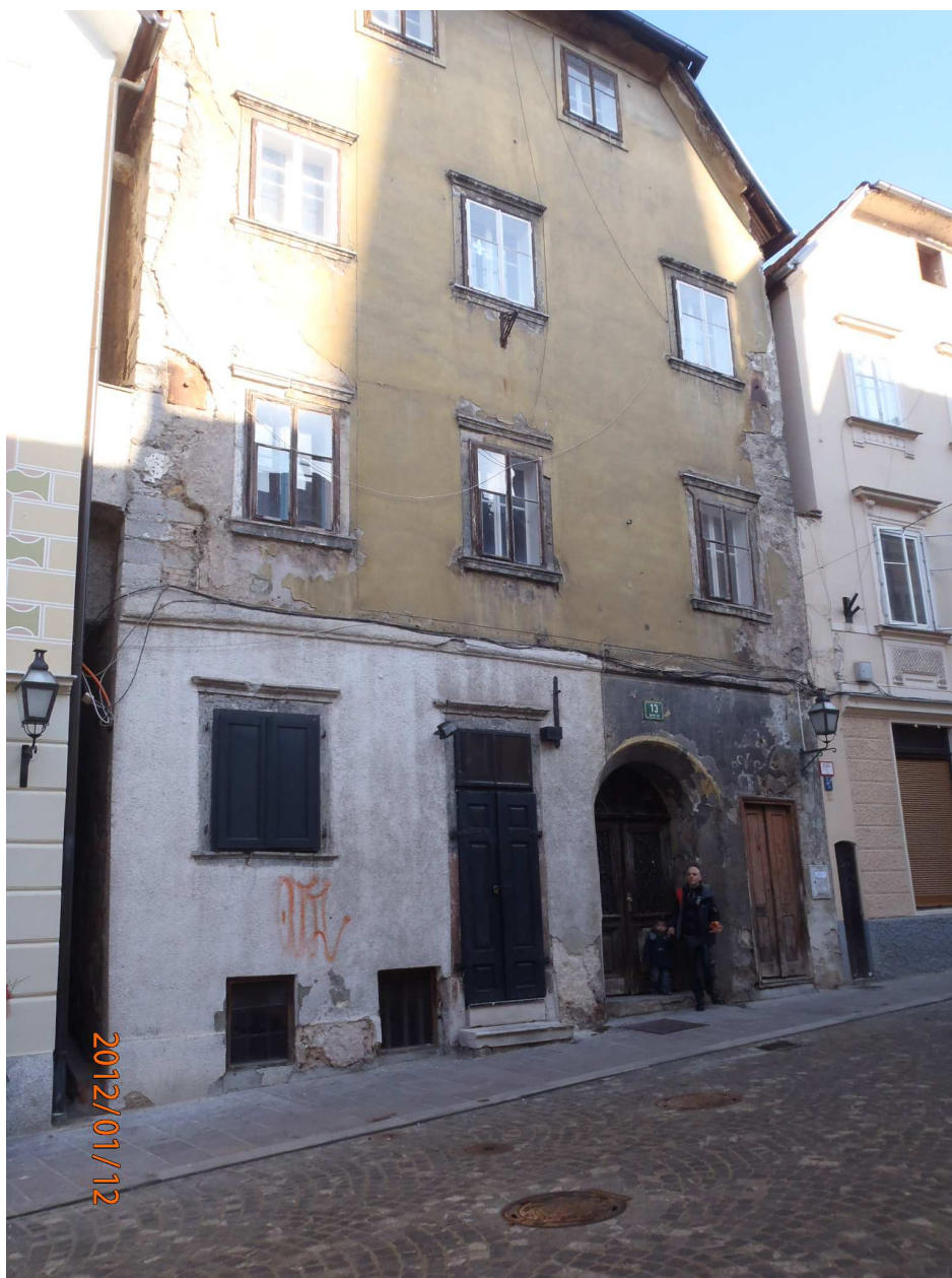
stavba Gornji trg 13, Ljubljana
