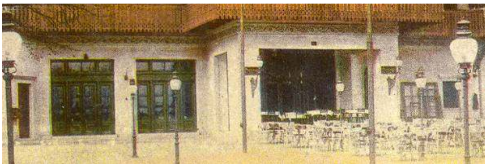
Detajl oken v pritličju
