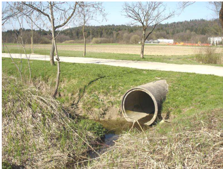
Slika 2: Obstoječi cevni prepust pod POTjo iz načrtovanega zadrževalnika ob Tehnološkem parku
