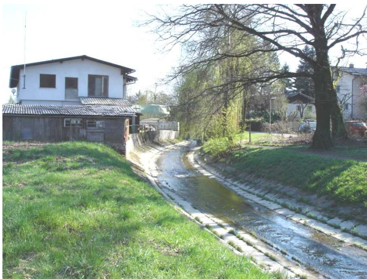
Slika 7: Glinščica pri objektu »dom šoferjev«
