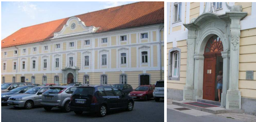
Slika 31: Fotografije obstoječega stanja dvorca
