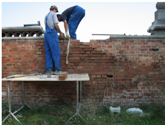
Ročna demontaža opečnega zidu
