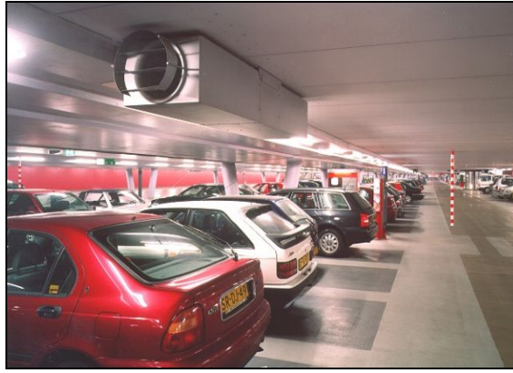
Slika 3: Primer prezračevalnega sistema v garažah
