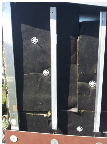
Slika 2: Premalo in napačen raster sider, ter velike reže med ploščami
