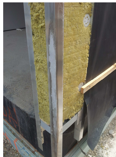
Slika 5: vgradnja izolacije od profila do profila
