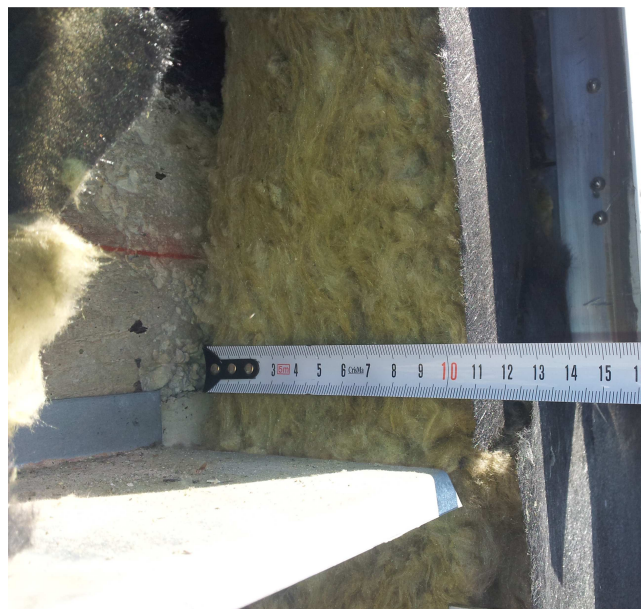
Slika 10: Debelina toplotna izolacije 10 cm - izolacija je prosto položena med Alu profile
