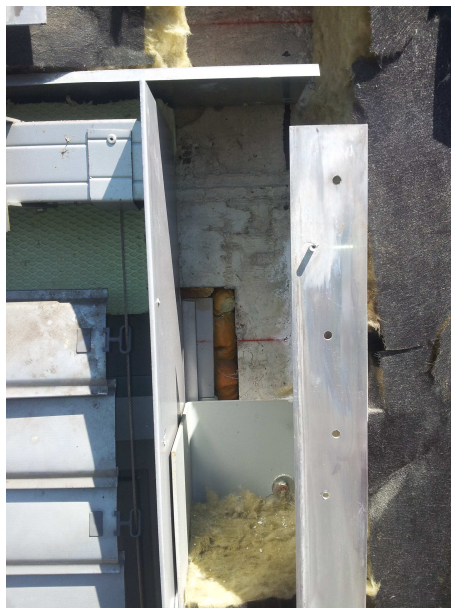
Slika 10: Debelina toplotna izolacije 10 cm - izolacija je prosto položena med Alu profile
