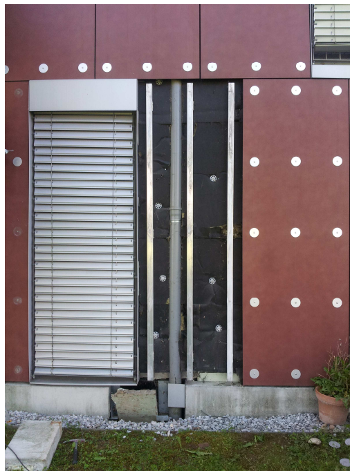
Slika 19: Prostor med vertikalno odtočno cevjo in zunanjo steno ni izoliran - toplotni most
