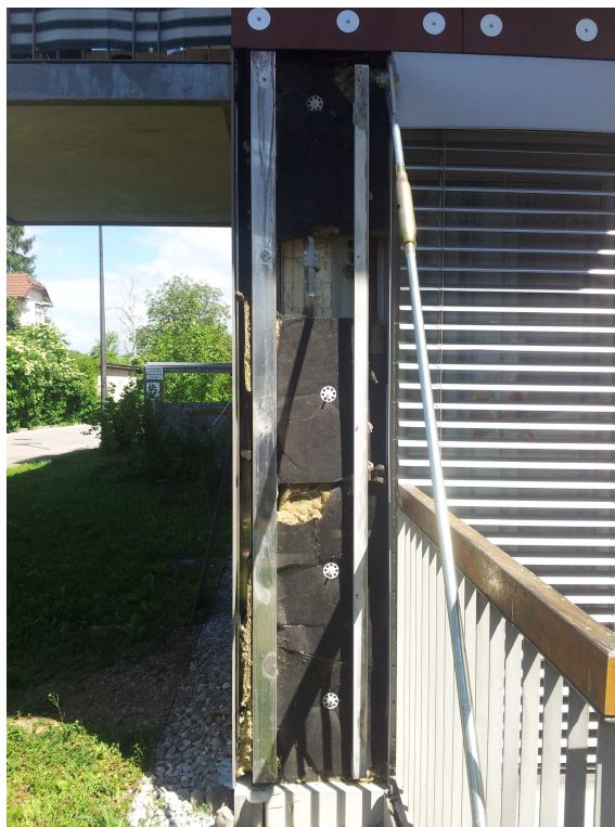
Slika 16: Neobdelana luknja v AB steni, ki je ostala od vezave opaža - toplotni most. Predviden vzrok madeža v stan. št. 13
