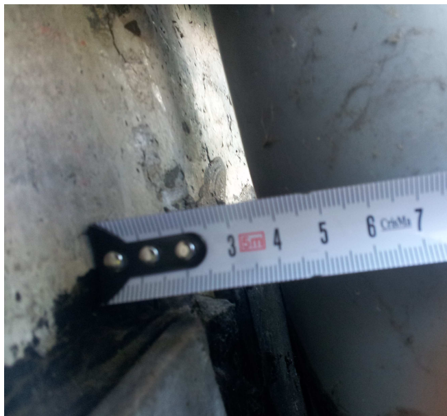
Slika 19: Prostor med vertikalno odtočno cevjo in zunanjo steno ni izoliran - toplotni most
