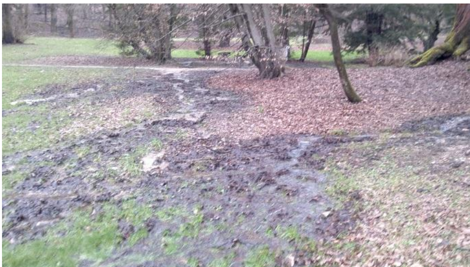
Slika 3 f: Nekontrolirano stekanje padavinskega odtoka po parkovnih površinah.
