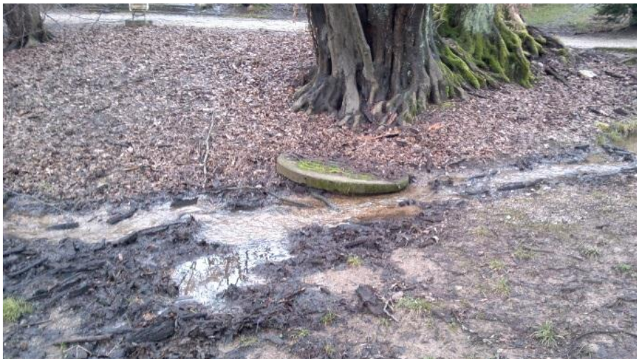
Slika 3b: Zamašen vtok v jašek.
