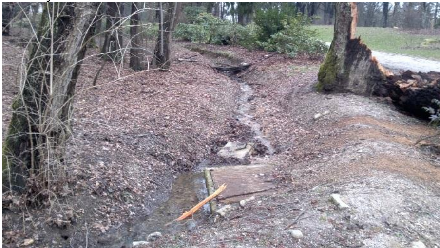
Slika 3a: Z naplavljenim listjem in zemljinozamašen vtok v peskolov
