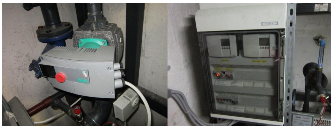
Slika 21: Črpalka za ogrevanje sanitarne vode WILO (levo) in regulatorja radiatorskega ogrevanja in priprave sanitarne vode DANFOSS ECL
