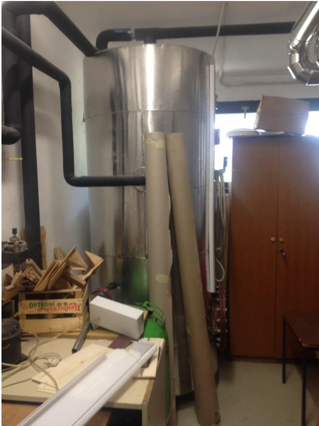
Slika 5.7: Posnetek akumulatorja tople vode
