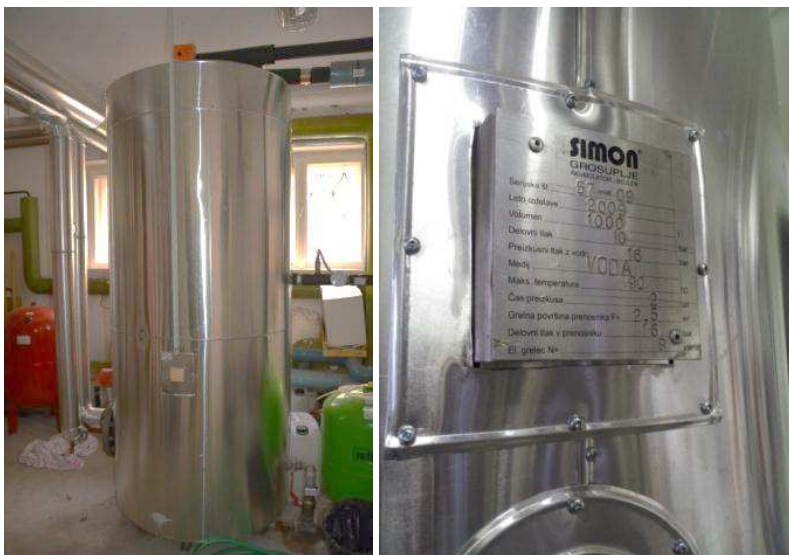
Slika 6.4: Hranilnik tople vode kapacitete 1000l; na levi sliki spodaj desno se nahaja ekspanzijska posoda.
