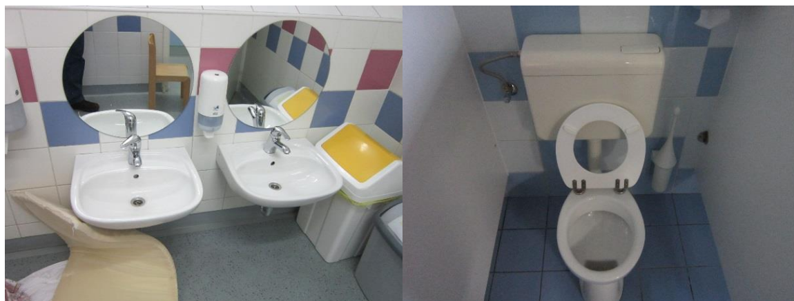
Slika 17: Enoročna mešalna baterija za umivalnik (levo) in nadometni WC kotliček brez varčevalne tipke (desno)
