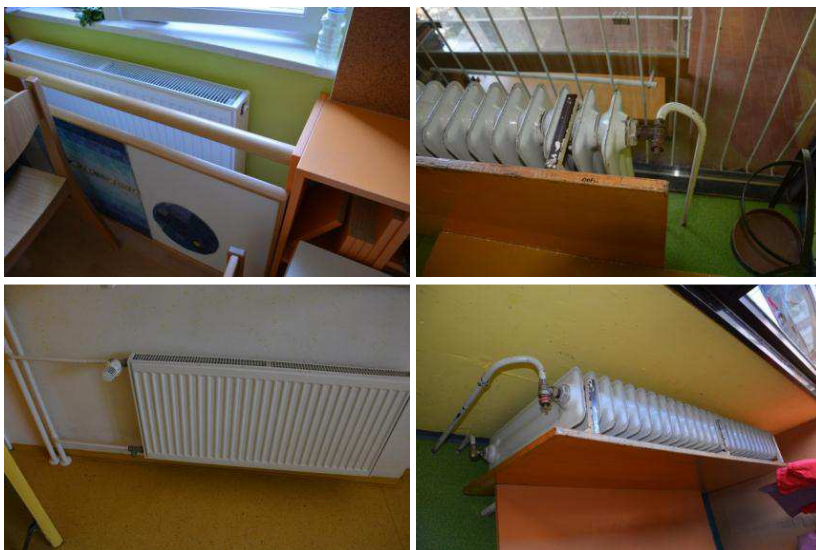
Slika 7.1: Panelni radiatorji s termostatskimi ventili (levo) in členkasti radiatorji z navadnimi ventili (desno)
