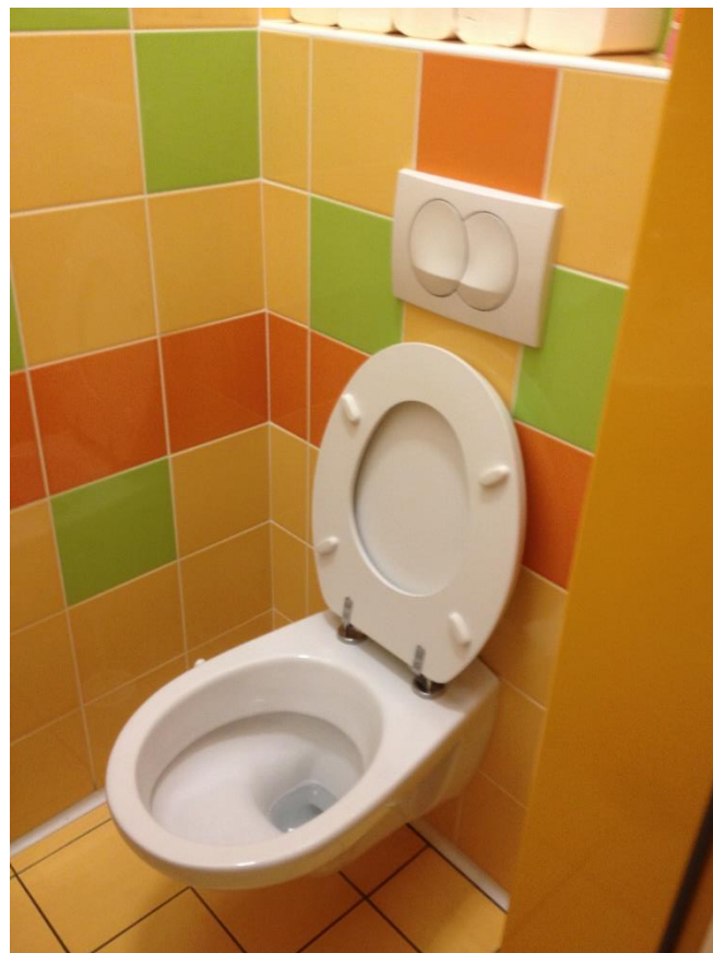
Slika 5.10: Posnetek WC-ja z varčevalno tipko
