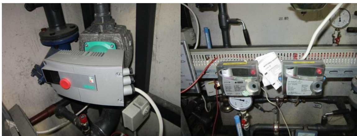
Slika 15: Obtočna črpalka EILO TOP E 30/1 - 10 EM (levo) in merilnik porabe toplotne energije ALLMES CF ECHO II (desno)
