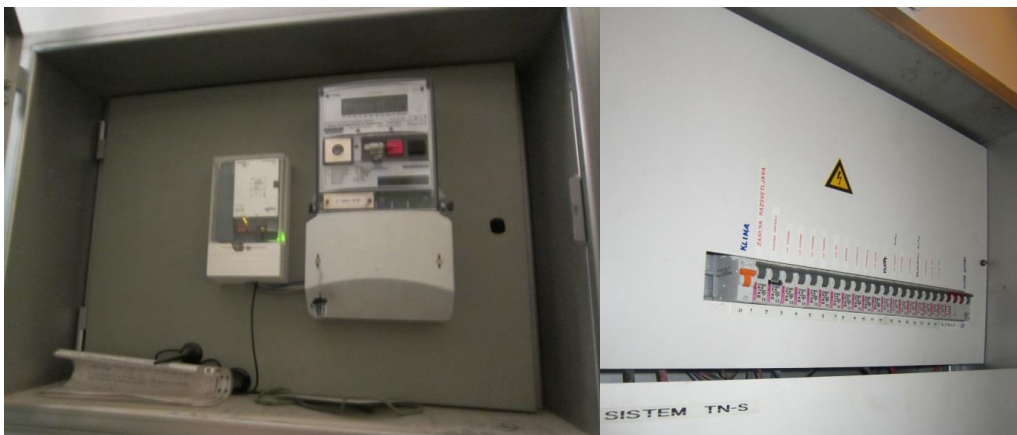
Slika 17: Posnetek glavnega razdelilca z merilno garnituro (levo) in posnetek etažnega razdelilca (desno)
