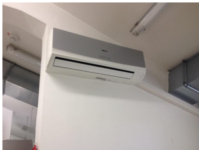
Slika 6.21: Posnetek split klimatske naprave Vir: lastni vir.
