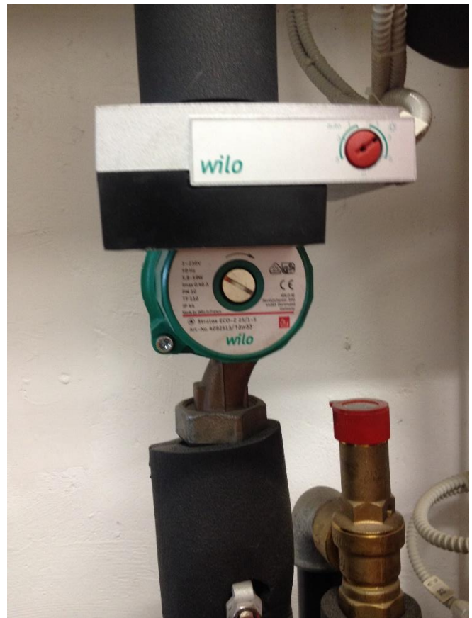
Slika 6.17: Posnetek obtočne črpalke Vir: lastni vir.
