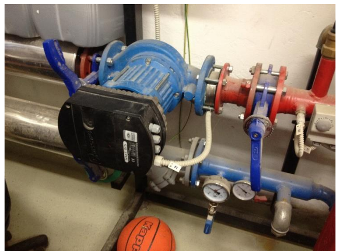
Slika 5.2: Posnetek obtočne črpalke WILO STRATOS 50/1-9 Vir: lastni vir.
