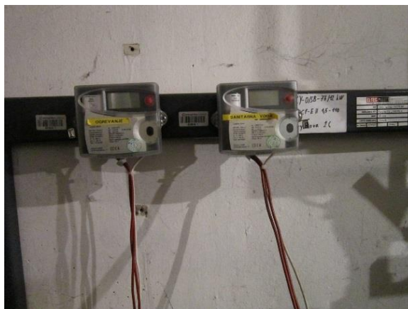
Slika 15: Merilnik porabe toplotne energije ALLMES CF ECHO II
