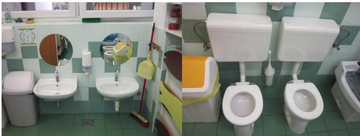
Slika 16: Enoročni mešalni bateriji za umivalnik (levo) in nadometna WC kotlička brez varčevalne tipke (desno)
