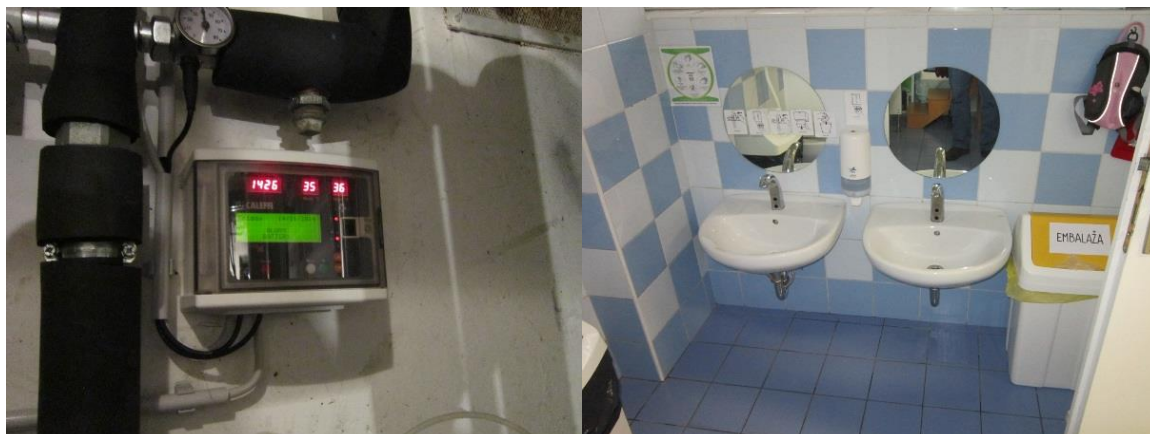
Slika 16: Regulator temperature sanitarne vode v razvodu (levo) in sanitarna baterija za umivalnik s senzorjem in ventilom EMV (desno)
