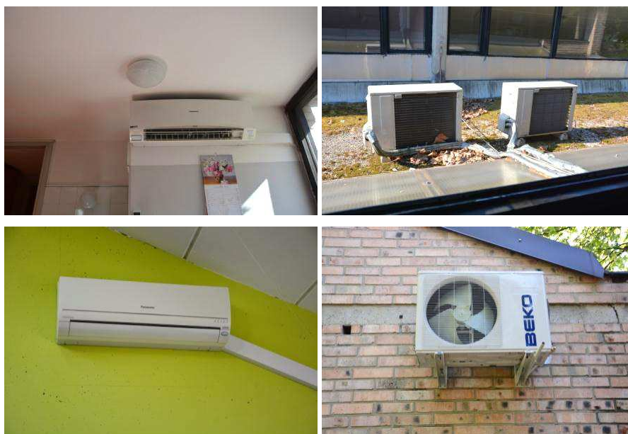
Slika 7.8: Notranje in zunanje enote hladilnih split sistemov
