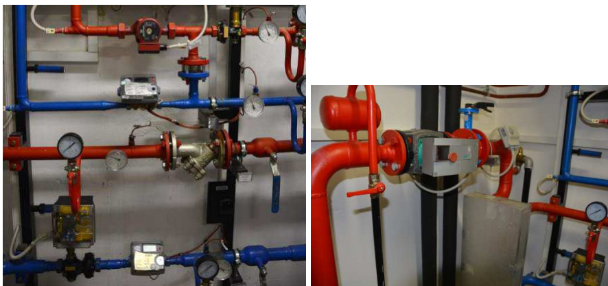
Slika 7.9: Obtočne črpalke v toplotni postaji
