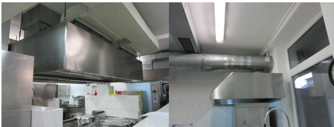
Slika 22: Odvodna kuhinjska napa z lovilcem maščobe (levo) in odvodna kuhinjska napa (desno)
