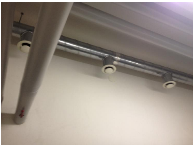
Slika 6.20: Posnetek odvoda zraka iz drugih kuhinjskih prostorov Vir: lastni vir.
