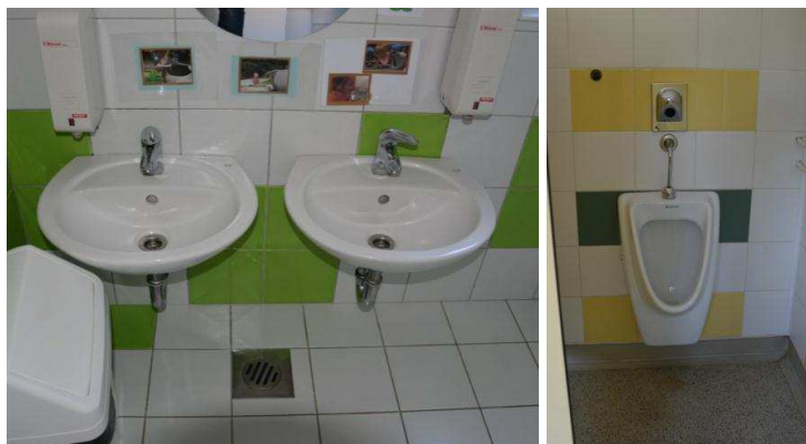
Slika 8.3: Umivalnik v toaletnih prostorih (levo) in pisoar s časovnim ventilom (desno)
