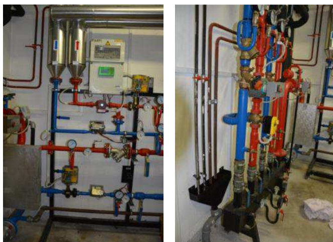
Slika 6.2: Razvod tople vode za STV (levo) in ogrevanje (desno)
