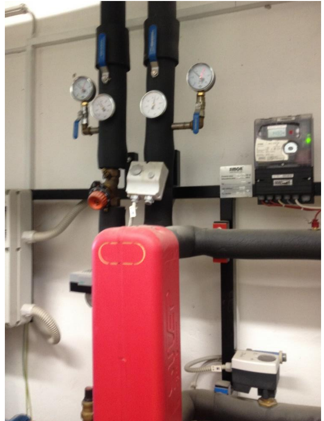
Slika 5.8: Razvod TSV iz razdelilca in kalorimeter
