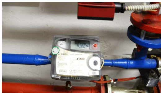
Slika 8.1: Kalorimeter za beleženje porabe za ogrevanje
