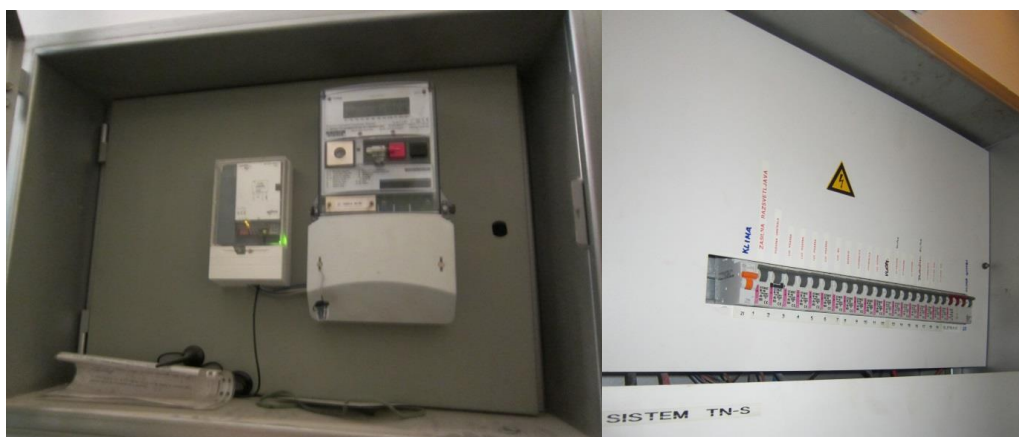
Slika 18: Posnetek glavnega razdelilca z merilno garnituro (levo) in posnetek etažnega razdelilca (desno)
