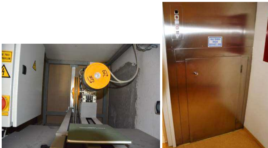
Slika 7.7: Pogon dvigala (levo) ter njegova zunanost (desno)
