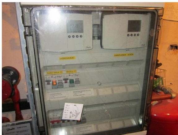
Slika 22: Regulatorja radiatorskega ogrevanja in priprave sanitarne vode DANFOSS COMFORT ECL
