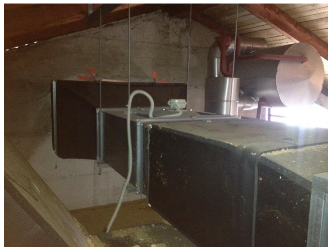
Slika 6.9: Posnetek dovoda prezračevalne naprave Vir: lastni vir.
