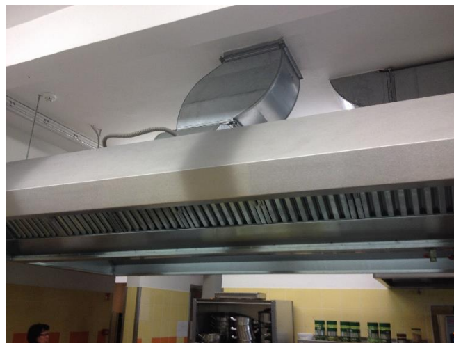
Slika 6.19: Posnetek kuhinjske nape Vir: lastni vir.
