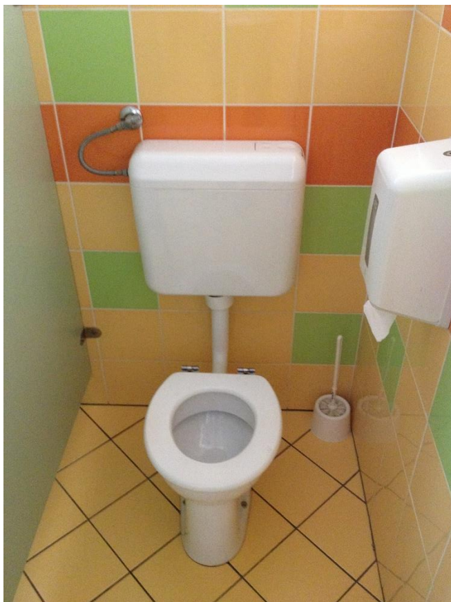
Slika 5.9: Posnetek WC-ja brez varčevalne tipke
