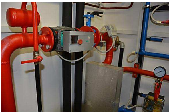
Slika 6.3: Frekvenčnik na strani ogrevanja ter toplotni prenosnik
