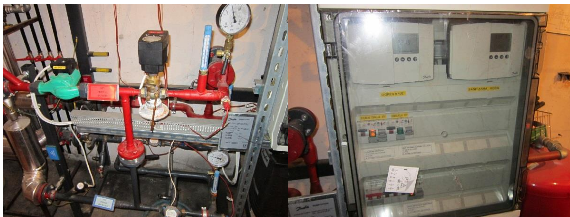
Slika 14: Kompaktna toplotna postaja ELTEC MULEJ HKY – 0/SB-72/12 (levo) in regulatorja radiatorskega ogrevanja in priprave sanitarne vode DANFOSS COMFORT (desno)
