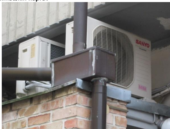
Slika 23: Zunanje enote SPLIT klimatskih naprav
