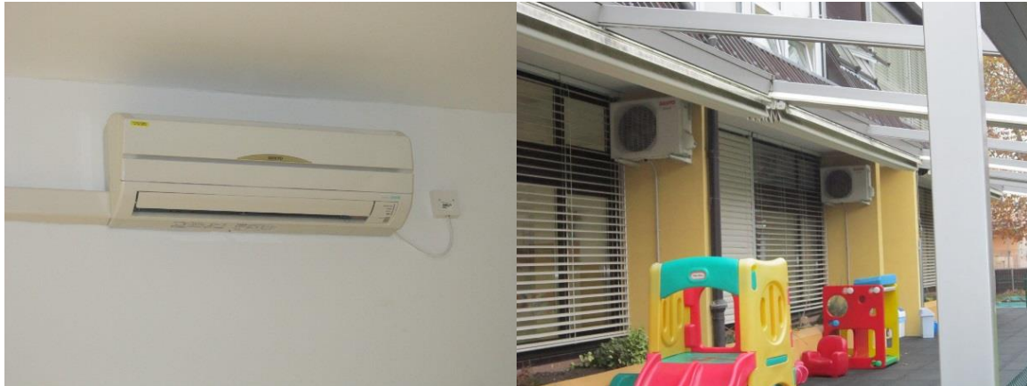
Slika 23: Notranja enota stenske SPLIT klimatske naprave (levo) in zunanje enote SPLIT klimatskih naprav (desno)
