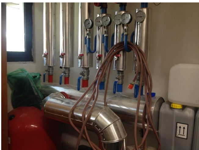
Slika 5.3: Posnetek razdelilca ogrevanja
