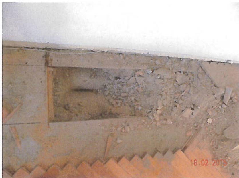
Slika 4.18 sonda tramovnega stropu nad pritličjem, N- S2
