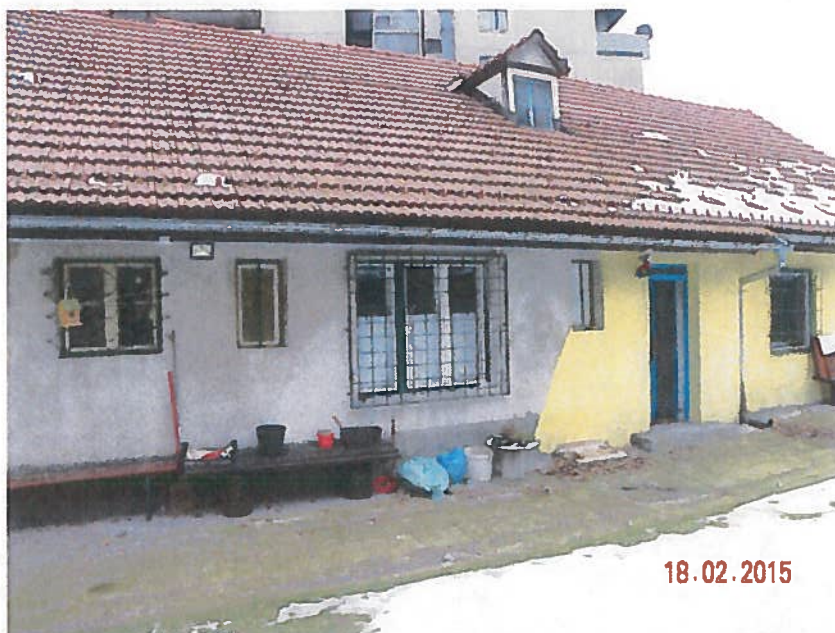
Slika 4.3 JZ fasada (pritlični del je vkopan)
