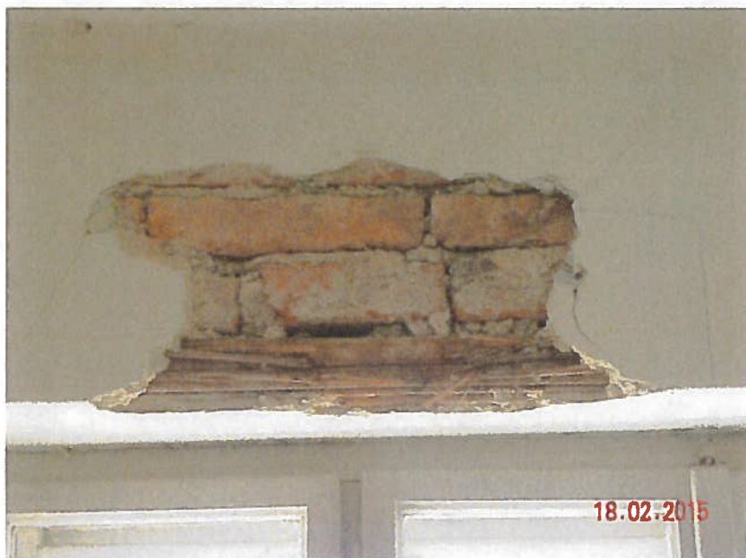
Slika 4.21 sonda M-Z1, preklada nad oknom v mansardi
