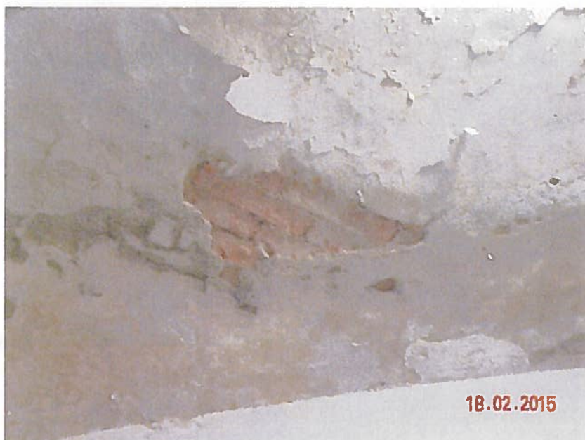
Slika 4.15 sonda stropu nad kletjo – P-S1
