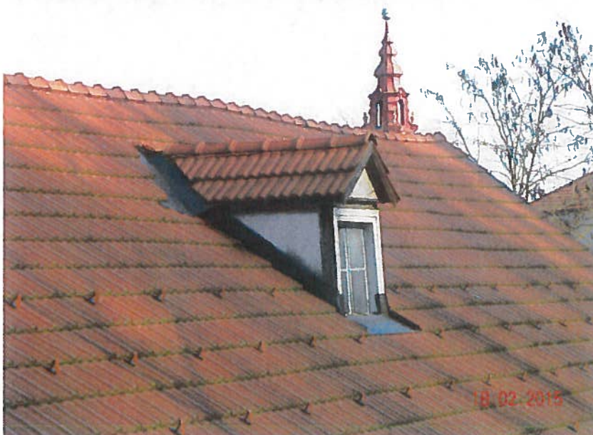
Slika 4.29 vidno je deformirano ostrešje (kritina sicer novejša)
