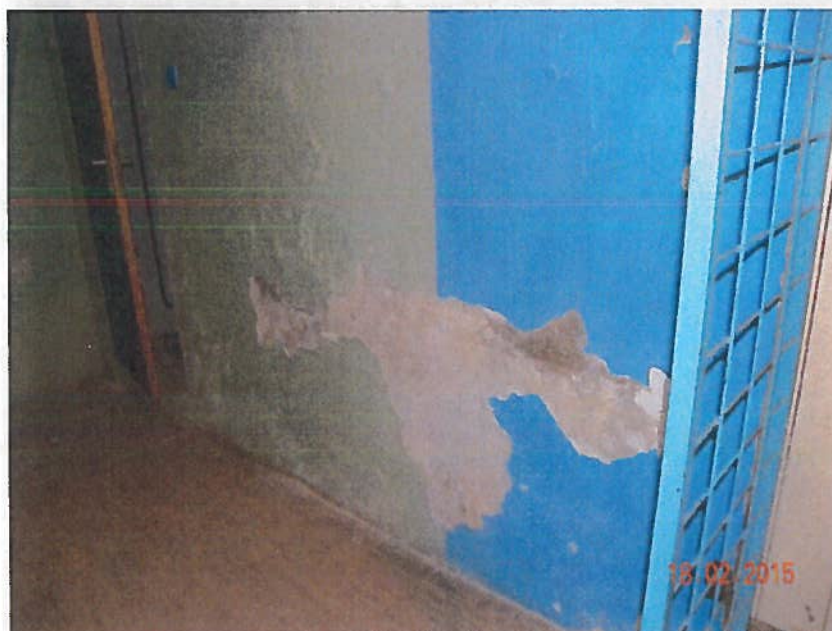
Slika 4.7 P-R23 zamakanje v pritličju – notranji zidovi
