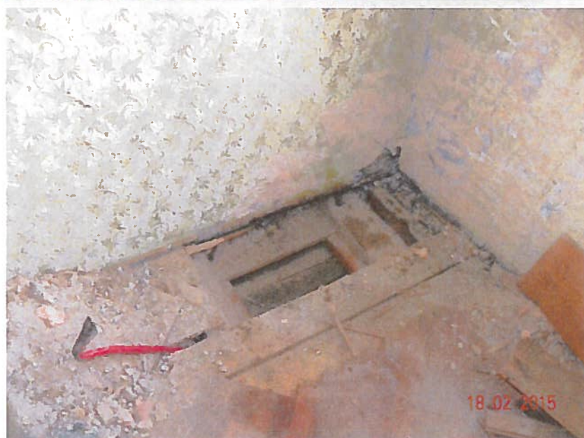
Slika 4.20 sonda stropu nad nadstropjem M-S4
