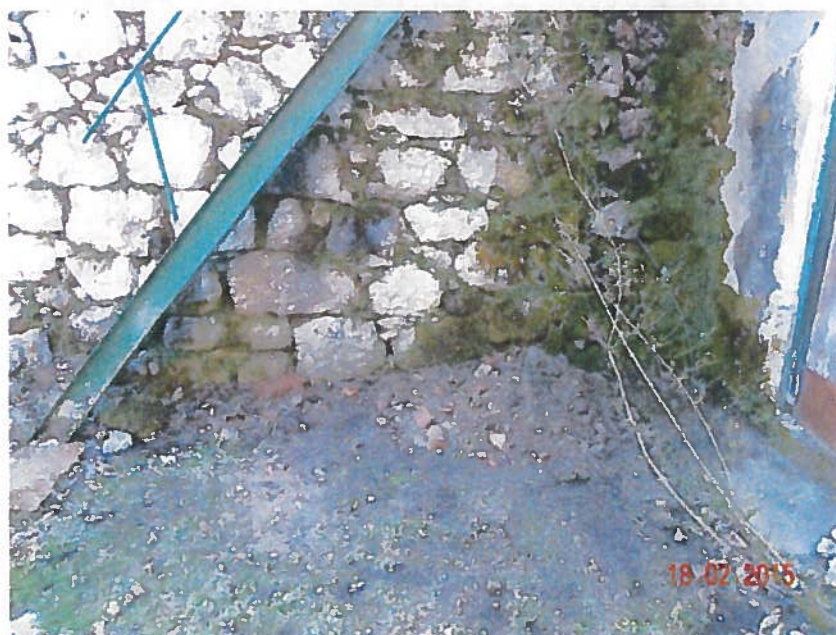
Slika 4.5 (del) oporni zid na terasi za hišo
