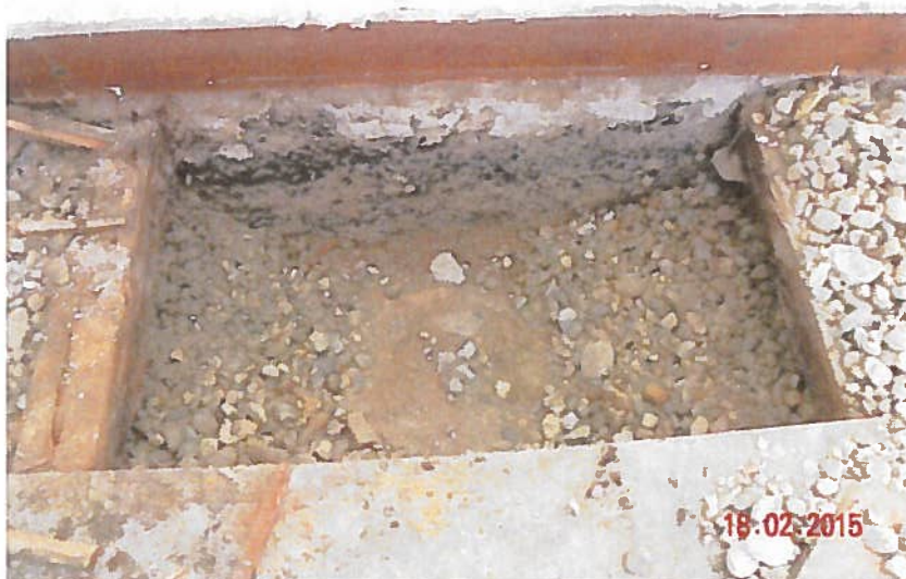
Slika 4.17 sonda N-S1 strop nad obokom pritličja
