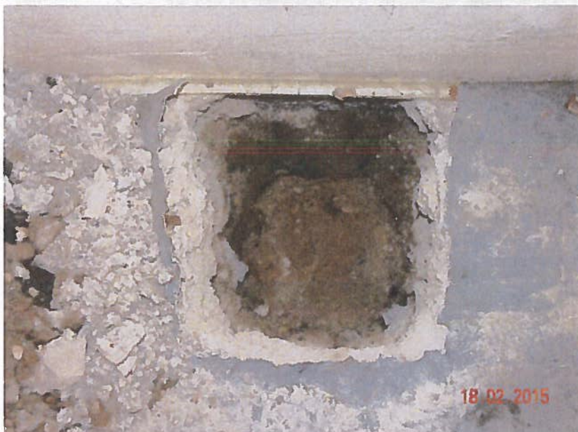
Slika 4.13 sonda P-T2 tla znotraj
