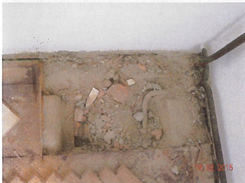
Slika 4.19 sonda stropu nad pritličjem – N-S3
