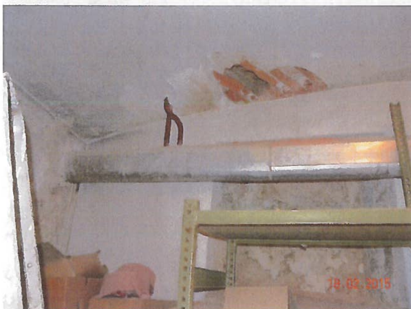
Slika 4.16 sonda stropu nad kletjo – P-S2
