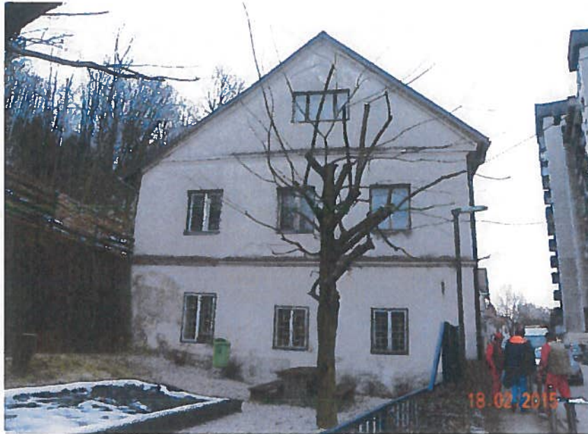
Slika 4.1 JV fasada z vidnim zamanjem
